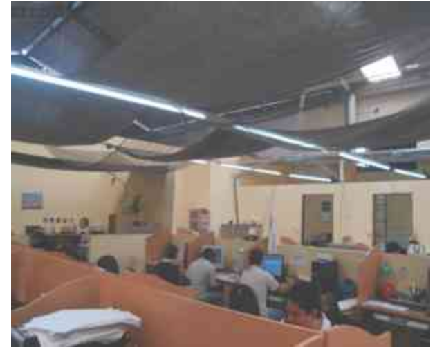
Imagen 20.- Muestra el Estado Actual del Inmueble, Foto Manuel Garduño
