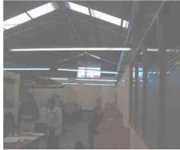
Imagen 27.- Muestra el Estado Actual del Inmueble, Foto Manuel Garduño
