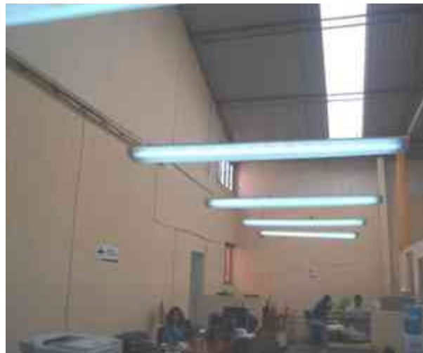
Imagen 25.- Muestra el Estado Actual del Inmueble, Foto Manuel Garduño
