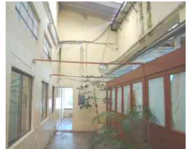
Imagen 26.- Muestra el Estado Actual del Inmueble, Foto Manuel Garduño
