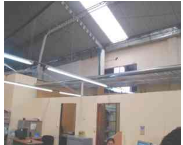
Imagen 22.- Muestra el Estado Actual del Inmueble, Foto Manuel Garduño
