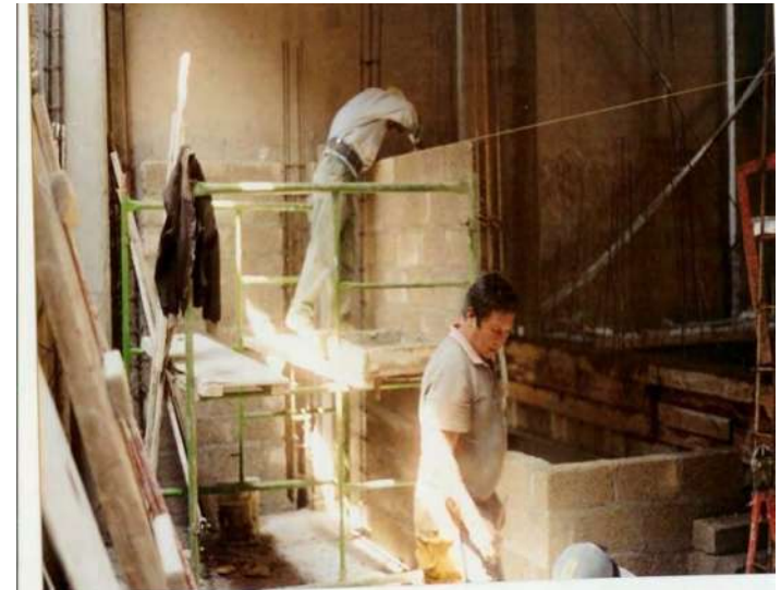
Fotografía 22. Muros divisorios de tabicón Fuente: Reporte fotográfico, bitácora de obra
