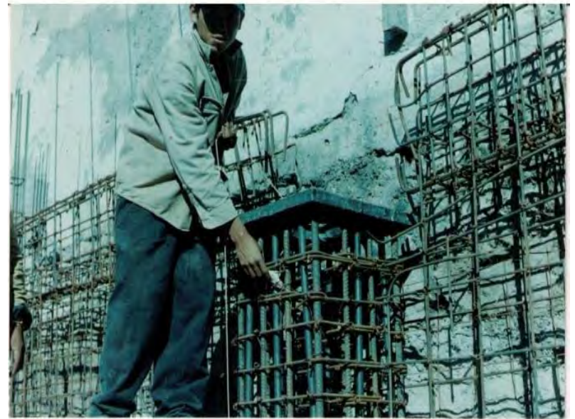
Fotografía 13. Se muestra el armado de columnas con acero de refuerzo f_y= 4200 \text{ kg/cm}^2 Fuente: Reporte fotográfico, bitácora de obra
