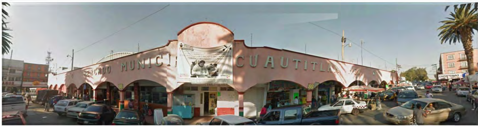
Larguillo fotográfico 3, Entorno comercial calle Tranquilino Delgado
