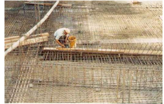
Fotografía 1. Armado acero de refuerzo en estacionamiento Cajón de cimentación.
