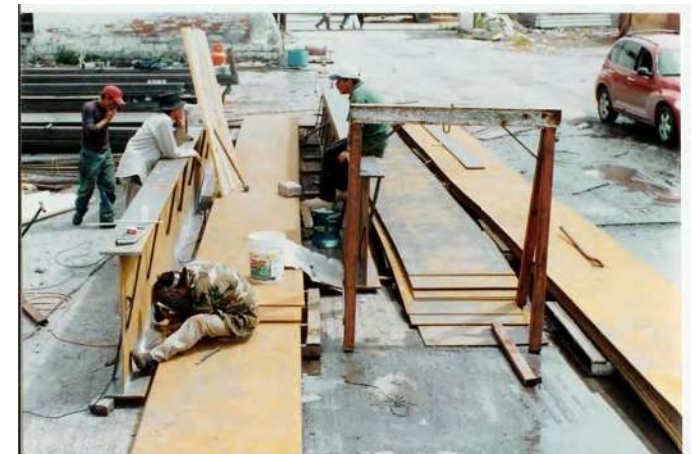
Fotografía 25. Fabricación de las vigas tipo "I" Fuente: Reporte fotográfico
