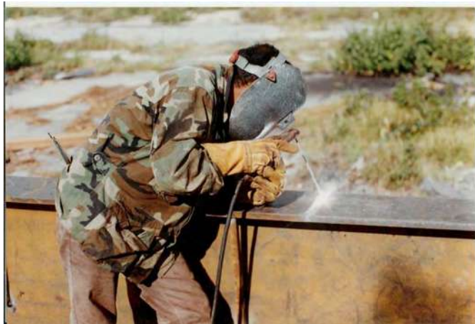
Fotografía 24. Fabricación de las vigas tipo "I" Fuente: Reporte fotográfico
