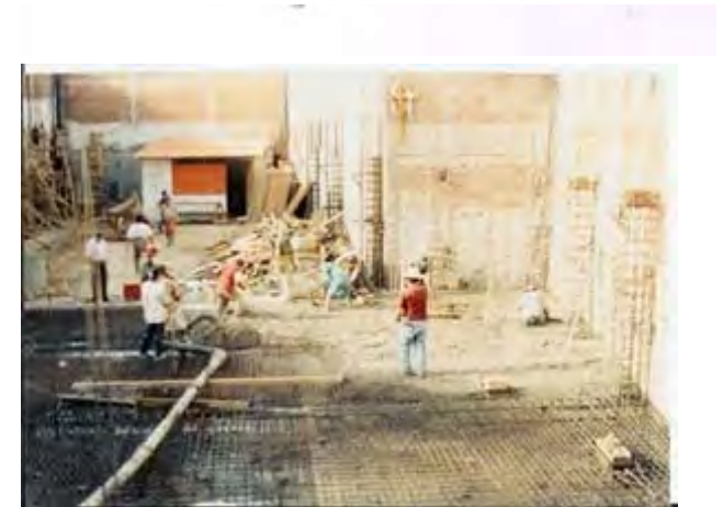
Fotografía 2. Colado de losa en Cajón de cimentación.
