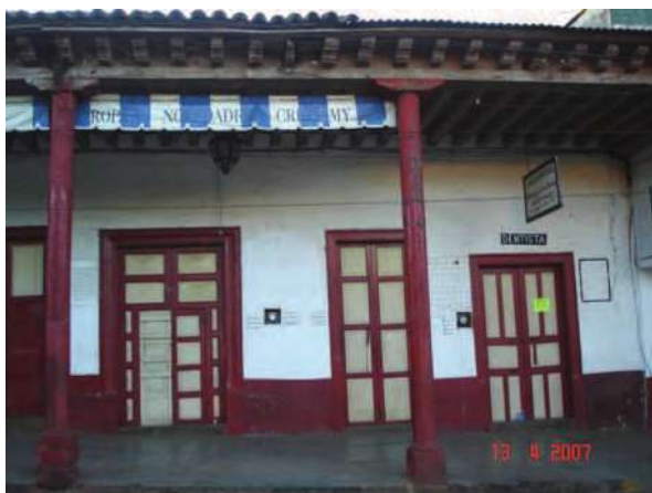
Fig. 40 Construcción de Arquitectura vernácula en los portales de Ario de Rosales, esta sin modificaciones contemporáneas, fotografía investigación de campo del autor
