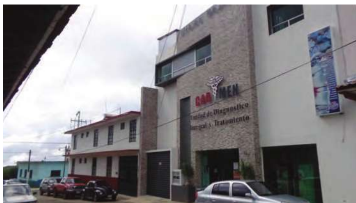
Fig. 63 Contexto actual inmediato al terreno para el proyecto, hospital privado, fotografía producto de investigación de campo del autor.
