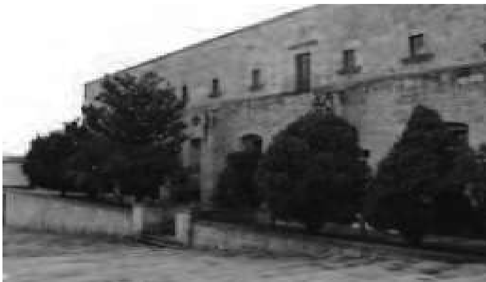
Fig. 15 casa de cultura de Morelia, conaculta (2011) http://sic.conaculta.gob.mx/ficha.php?table=centro_cultural&table_id=253
