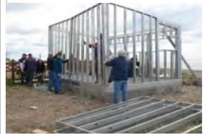
Imagen 139 Colocación de Sistema Steel Frame
