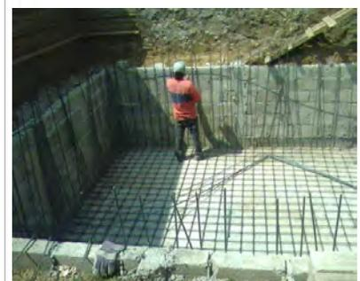
Imagen 124 Suministro y colocación de acero de refuerzo
