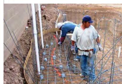
Imagen 127 Suministro y colocación de tubería (instalación eléctrica)
