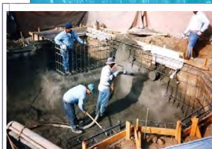
Imagen 125 Suministro y colocación de concreto lanzado (proyectado)
