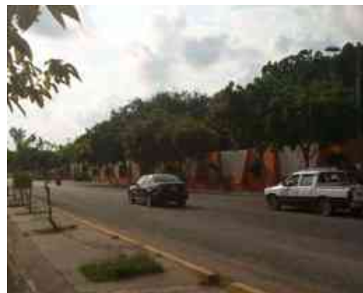
Fig142.- servicio de pavimentación y banqueta sobre la avenida Melchor Ocampo / Fuente: Foto tomada por Cristian Cabrera
