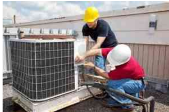
Fig 20.- Aire acondicionado como medida de control de temperatura/ Fuente: http://limacallao.olx.com.pe/equipos-contra-incendio
