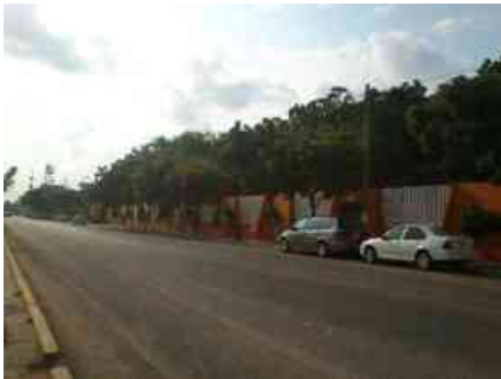
Fig127.- Av. Melchor Ocampo, muestra de pavimentación en la ciudad de Lázaro Cárdenas/Fuente: Foto tomada por Cristian Cabrera
