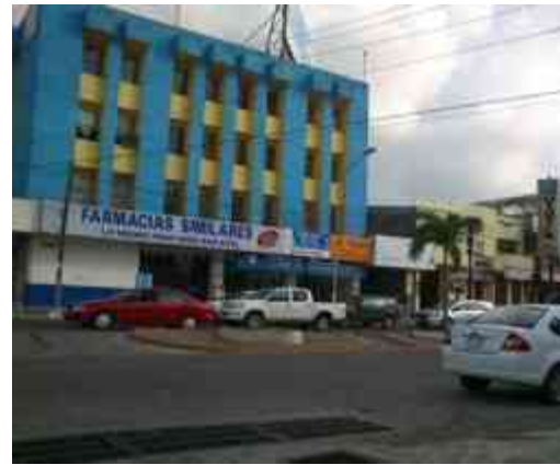
Fig128.- Alcantarillado sobre avenida y red de energía eléctrica / Fuente: Foto tomada por Cristian Cabrera
