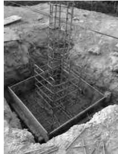
Fig151. Construcción de una zapata aislada / Fuente: http://arquinathalia.blogspot.mx/2012/08/cimentaciones-zapatas.html
