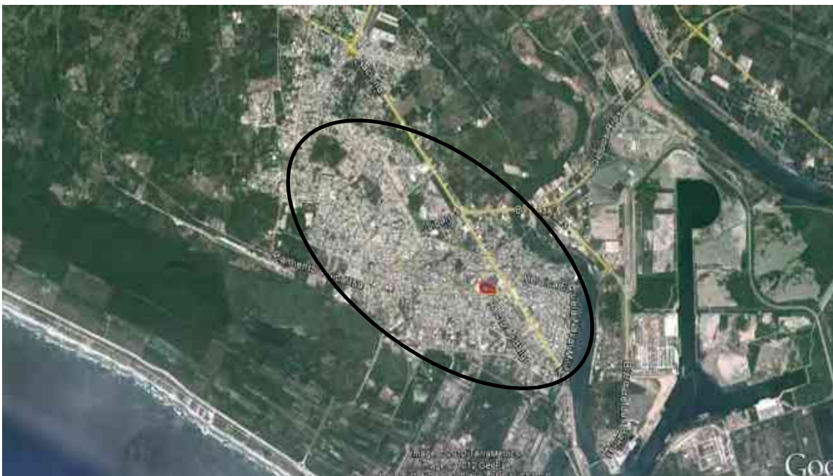
Fig123.- Delimitación de estudio del centro de población de la ciudad de Lázaro Cárdenas / Fuente: Imagen tomada de Google Earth
