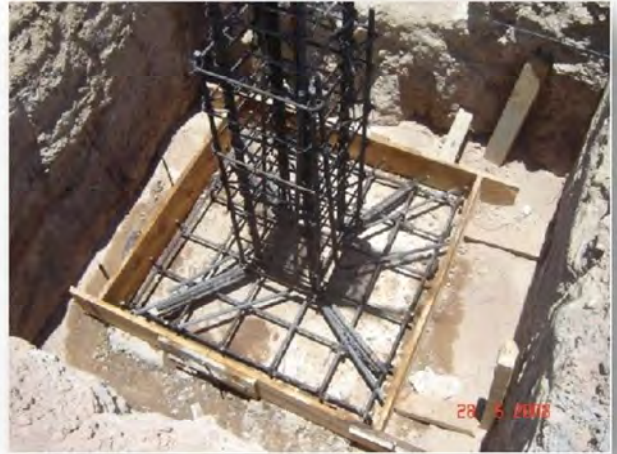
IMAGEN 44. ZAPATA AISLADA FUENTE: www.arqhys.com [OCTUBRE 2012]
