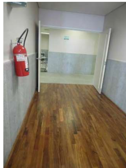
Imagen 26. Cambios de texturas en pisos y colores sobrios en paredes. Imagen tomada por Anabel Becerra Espino.
