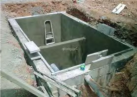
FIG. 75, CONSTRUCCIÓN DE FOSA SÉPTICA, FUENTE: [\[http://www.arqhys.com/wp-content/fotos/2012/12/Como-instalar-una-fosa-s%C3%A9ptica.jpg\]](http://www.arqhys.com/wp-content/fotos/2012/12/Como-instalar-una-fosa-s%C3%A9ptica.jpg). 22.09.13]
