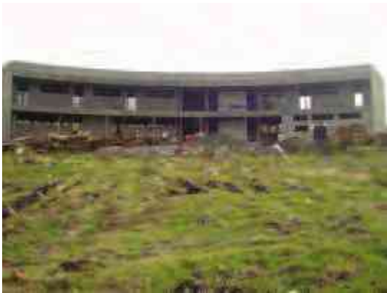
Imagen 14: Edificio de laboratorios en construcción sobre el terreno., imagen cortesía de Planeación Universitaria, Noviembre 12, 2012
