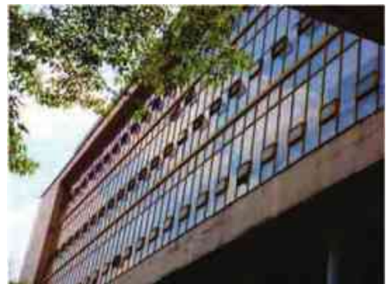
Imagen 45: Fachada lateral de la Facultad de Medicina UNAM, fuente: unam.mx/visión/12w3 fecha: Diciembre 2012
