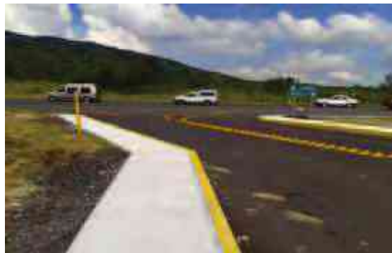
Imagen 22, 23 y 24: Infraestructura del lugar, fotografías por AZA, Octubre 2012.
