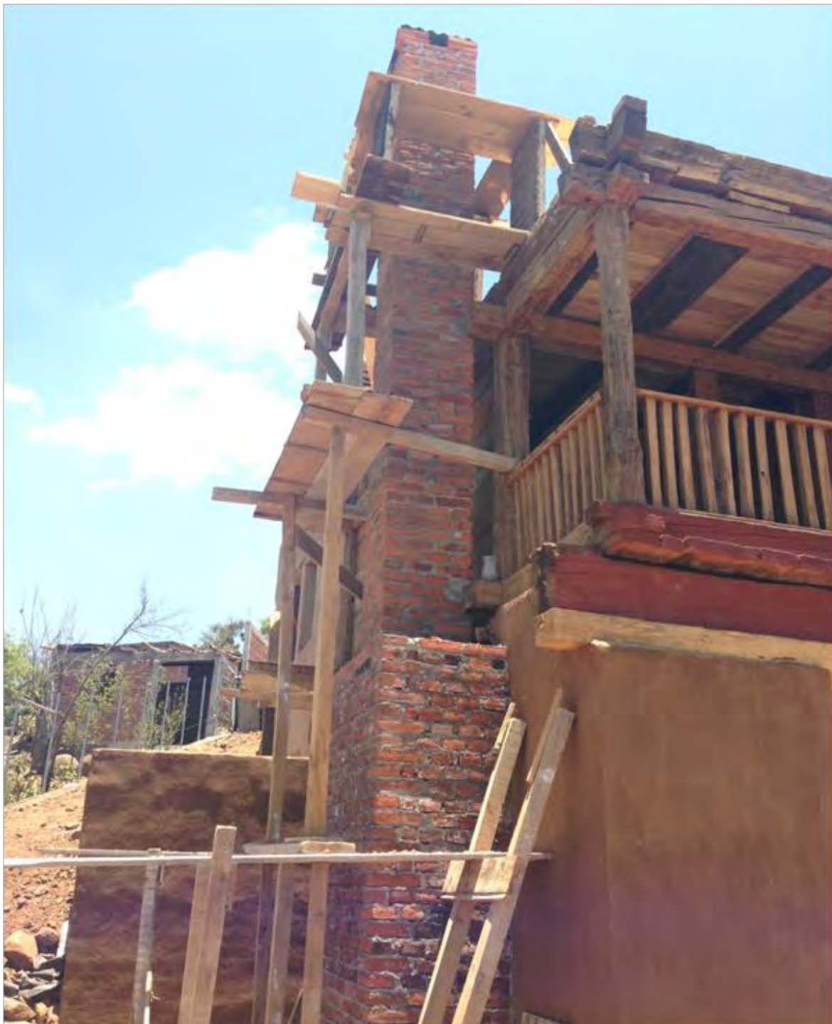
fotografía: Francisco López (2013), forjado de chimenea, Ichupio, Mx.
