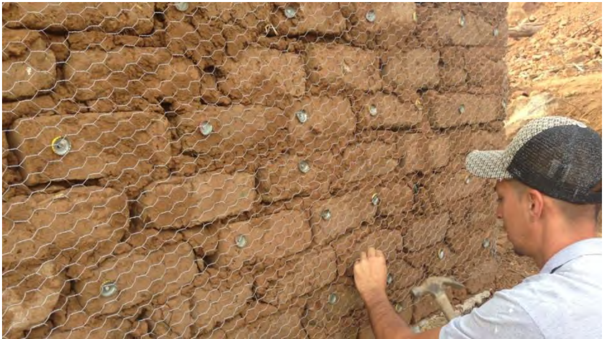
fotografía: Francisco López (2013), preparación para recibir repellado de barro, Ichupio, Mx.
