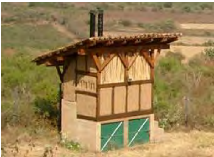
fotografía: Holger Hieronimi (2005), baño seco, Erongarícuaro, Mx.
