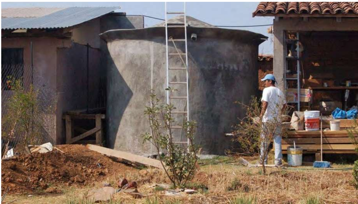
fotografía: Holger Hieronimi (2007), cisterna de ferrocemento terminada en Erongarícuaro, Mx.
