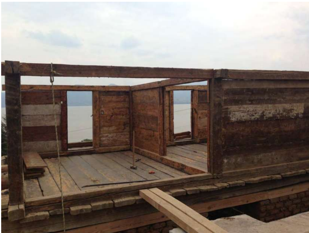
fotografía: Francisco López (2013), montaje de la troje con el sistema constructivo original, Ichupio, Mx.
