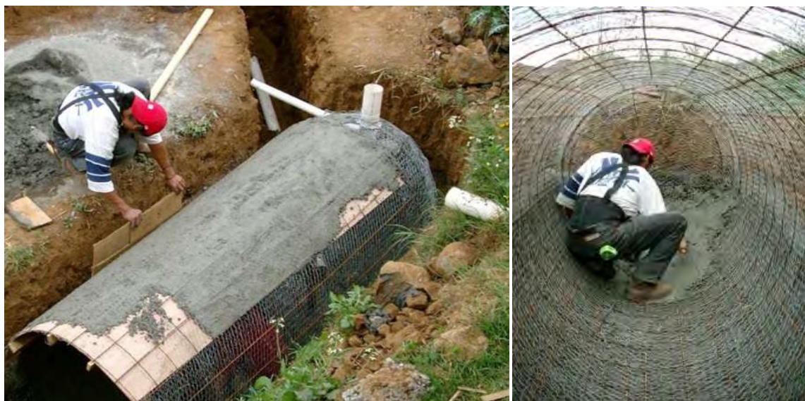
fotografía: Holger Hieronimi (2007), construcción de biodigestor anaeróbico de ferrocemento, Erongaricuaro. Mx
