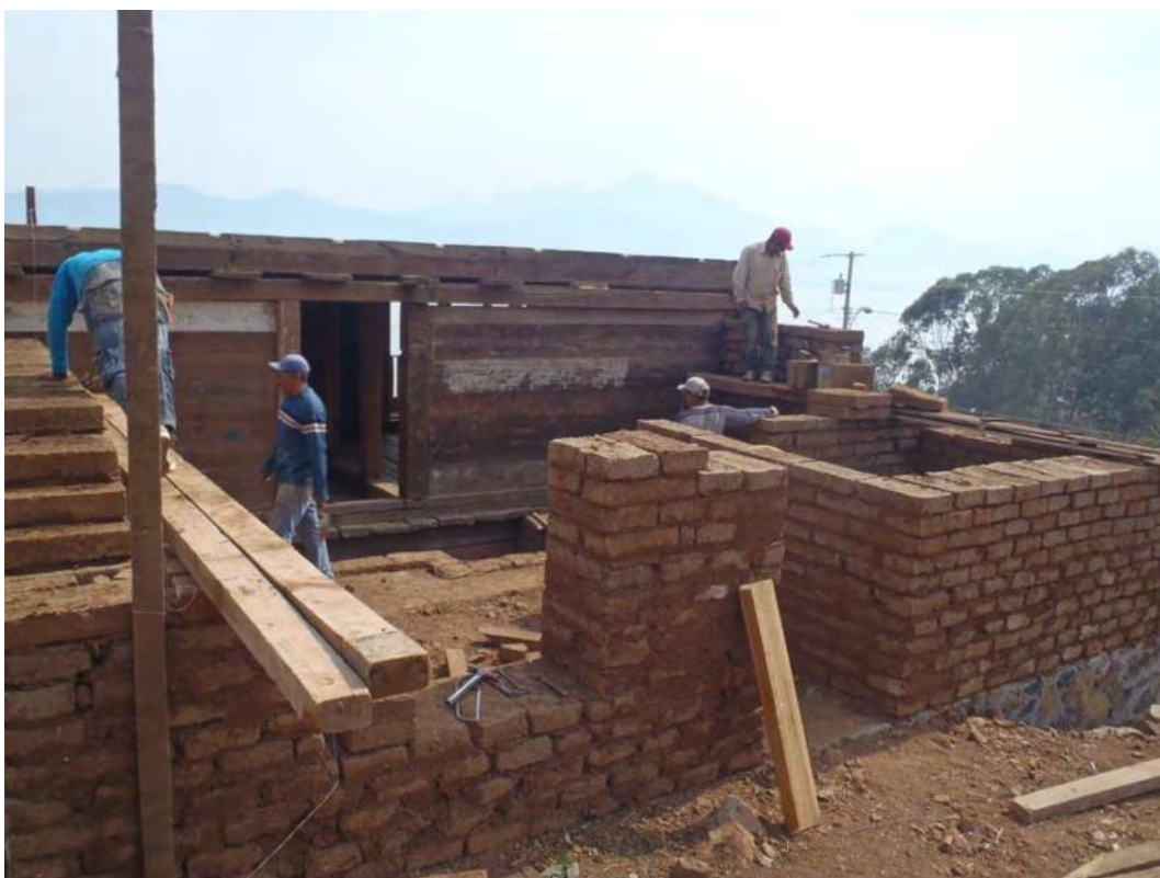
fotografía: Francisco López (2013), construcción de muros con block de adobe, Ichupio, Mx.
