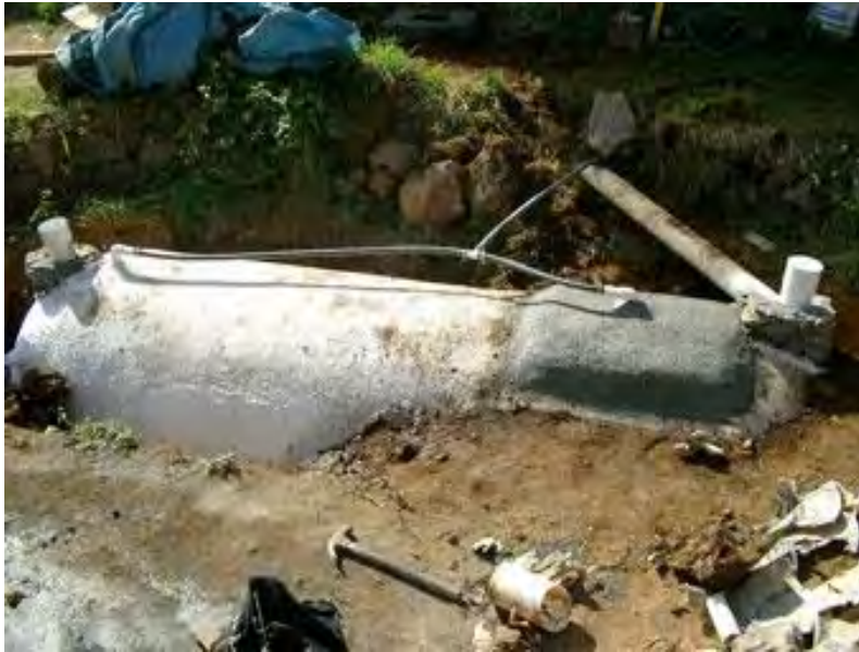
fotografía: Holger Hieronimi (2005), biodigestor, Erongarícuaro, Mx.
