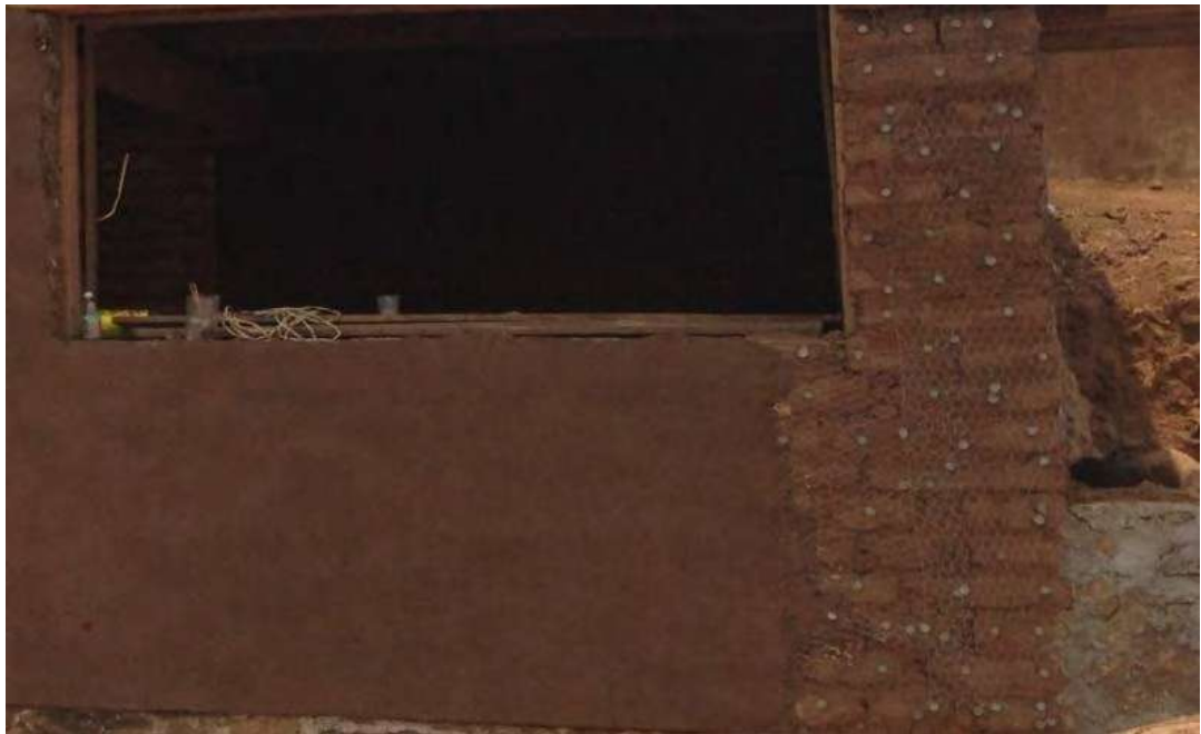
fotografía: Francisco López (2013), aplanado repellado de arcilla, Ichupio, Mx.
