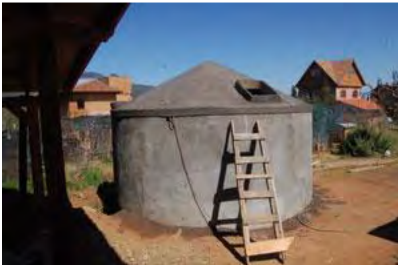
fotografía: Holger Hieronimi (2005), cisterna de ferrocemento, Erongarícuaro, Mx.
