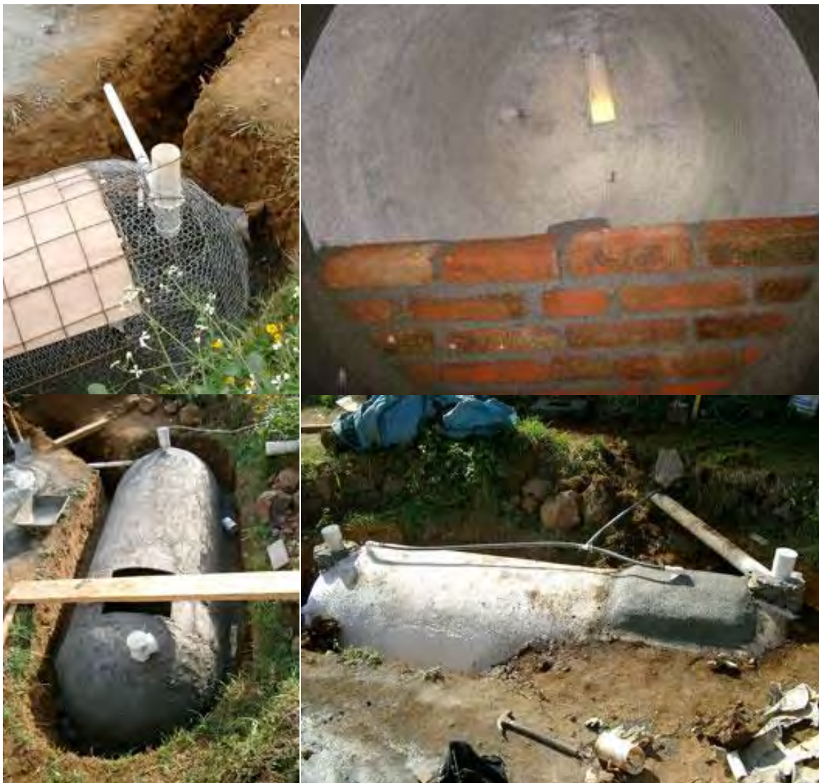
fotografía: Holger Hieronimi (2007), proceso constructivo del biodigestor anaeróbico de ferrocemento, Erongarícuaro, Mx.
