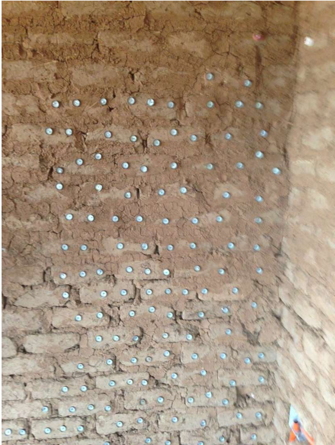
fotografía: Francisco López (2013), sujeción para refuerzo de malla en repellado, Ichupio, Mx.
