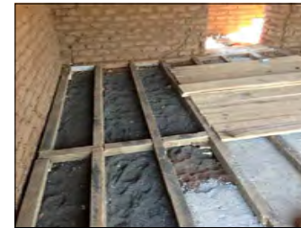
PISO DE TABLONES DE MADERA SOBRE BASTIDORES
