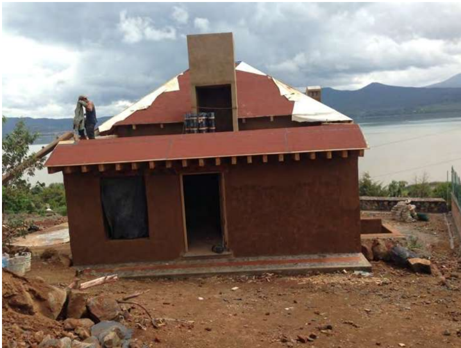
fotografía: Francisco López (2013), impermeabilizante prefabricado, Ichupio, Mx.
