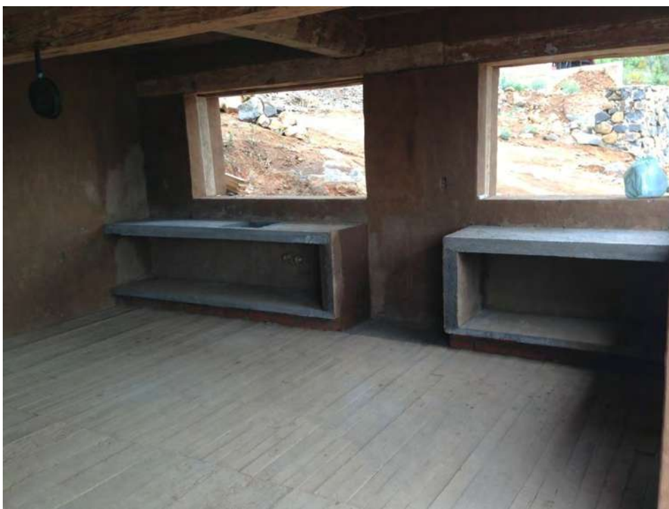
fotografía: Francisco López (2013), barras en cocina de concreto armado, Ichupio, Mx.
