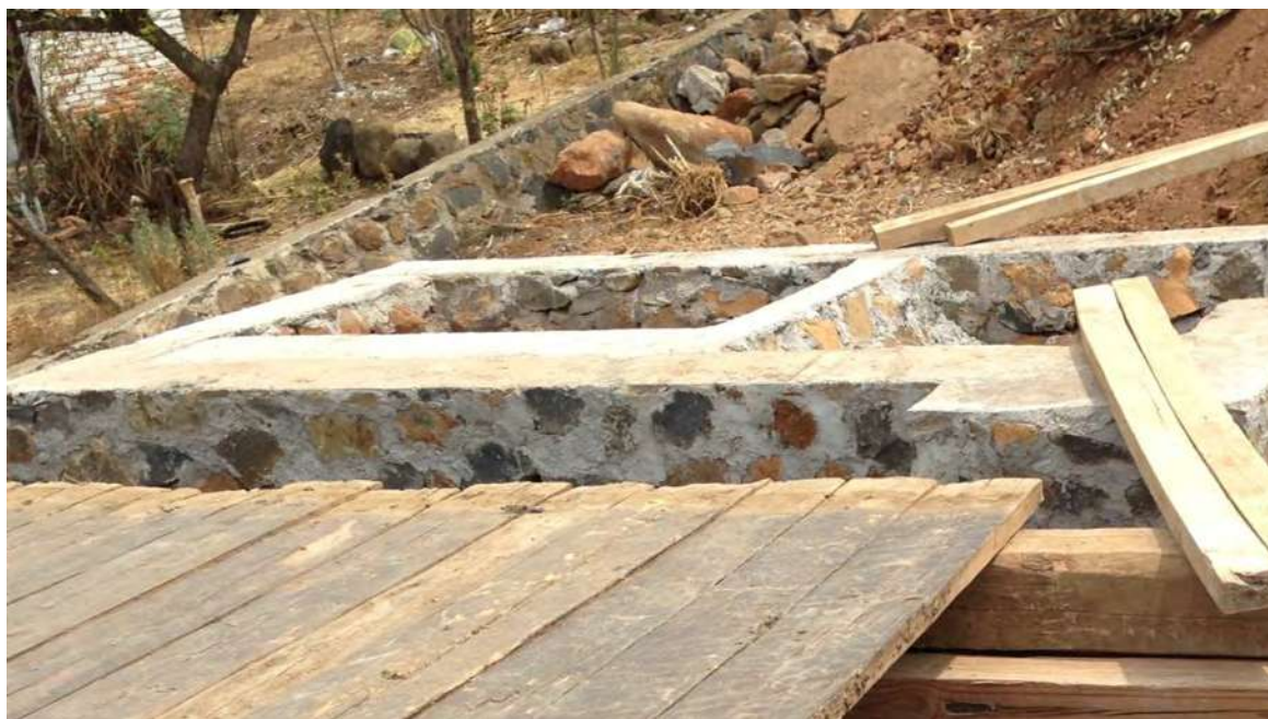
fotografía: Francisco López (2013), cimentación de mampostería de piedra del sitio, Ichupio, Mx.
