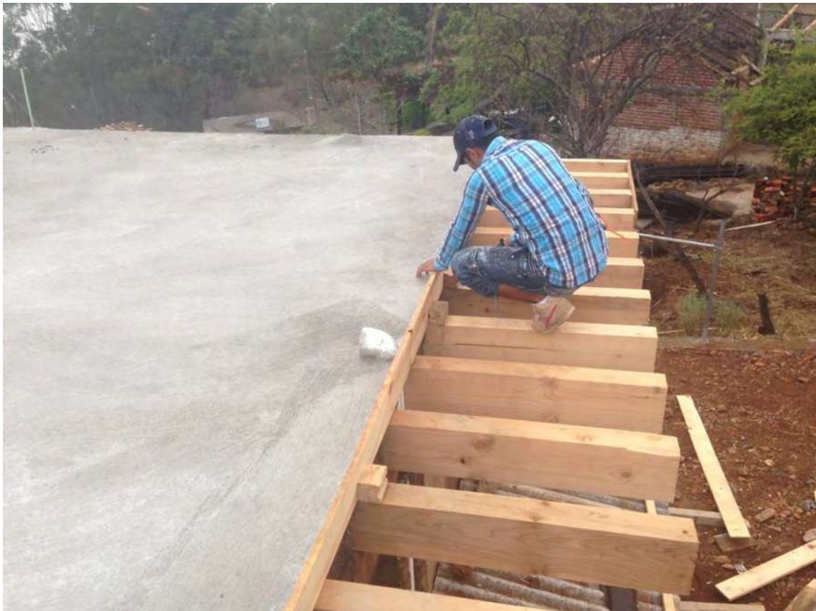
fotografía: Francisco López (2013), losa de concreto armado y pergolado fontal de madera, Ichupio, Mx.
