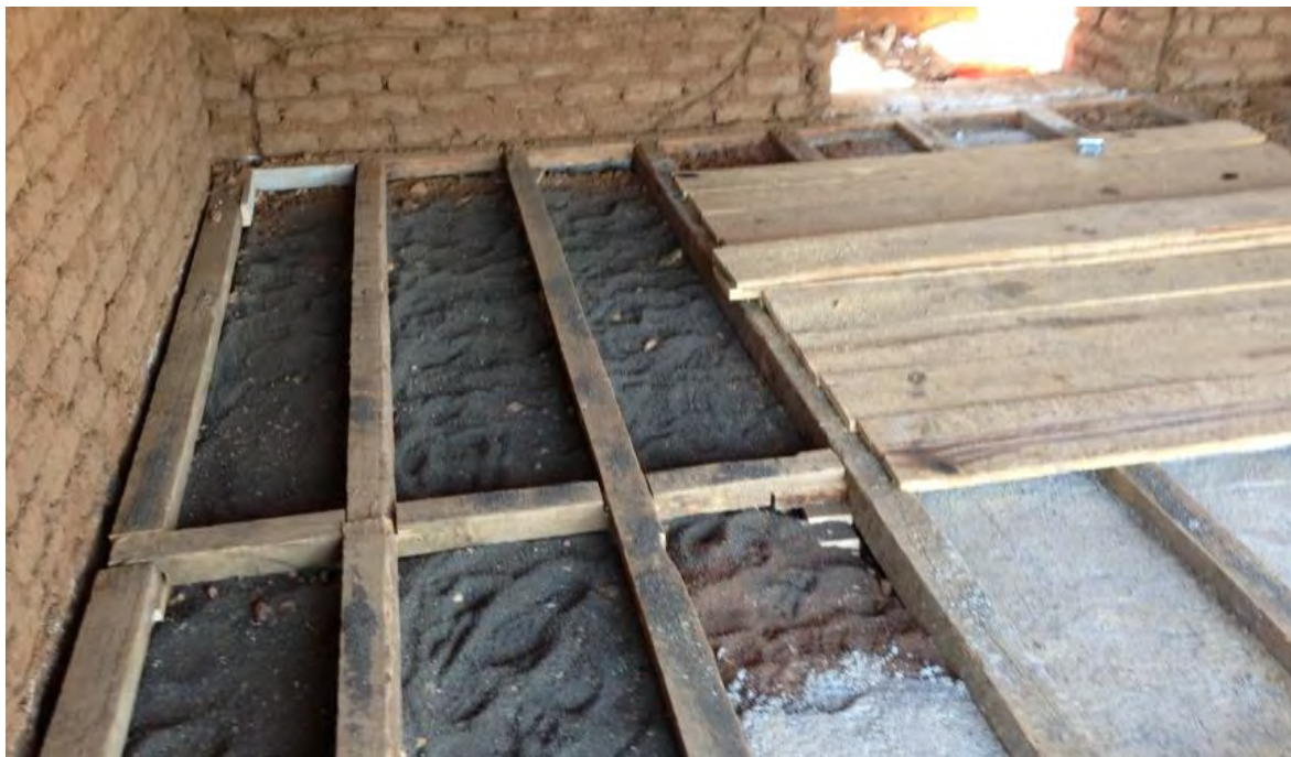
fotografía: Francisco López (2013), preparación para recibir piso de madera, Ichupio, Mx.
