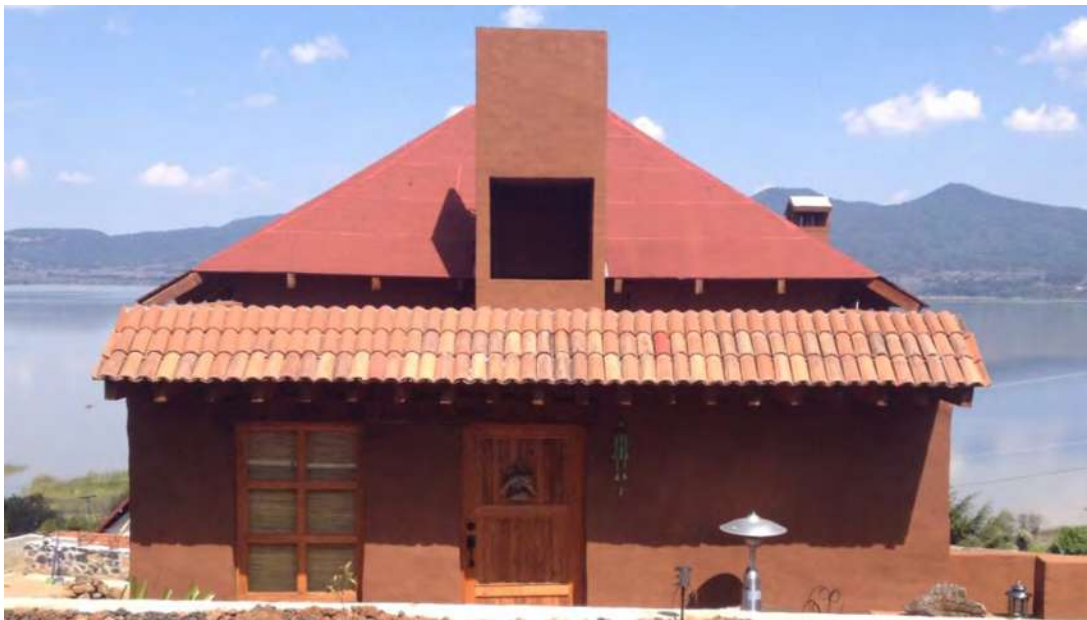
fotografía: Francisco López (2013), impermeabilizante prefabricado en techumbres, Ichupio, Mx.
