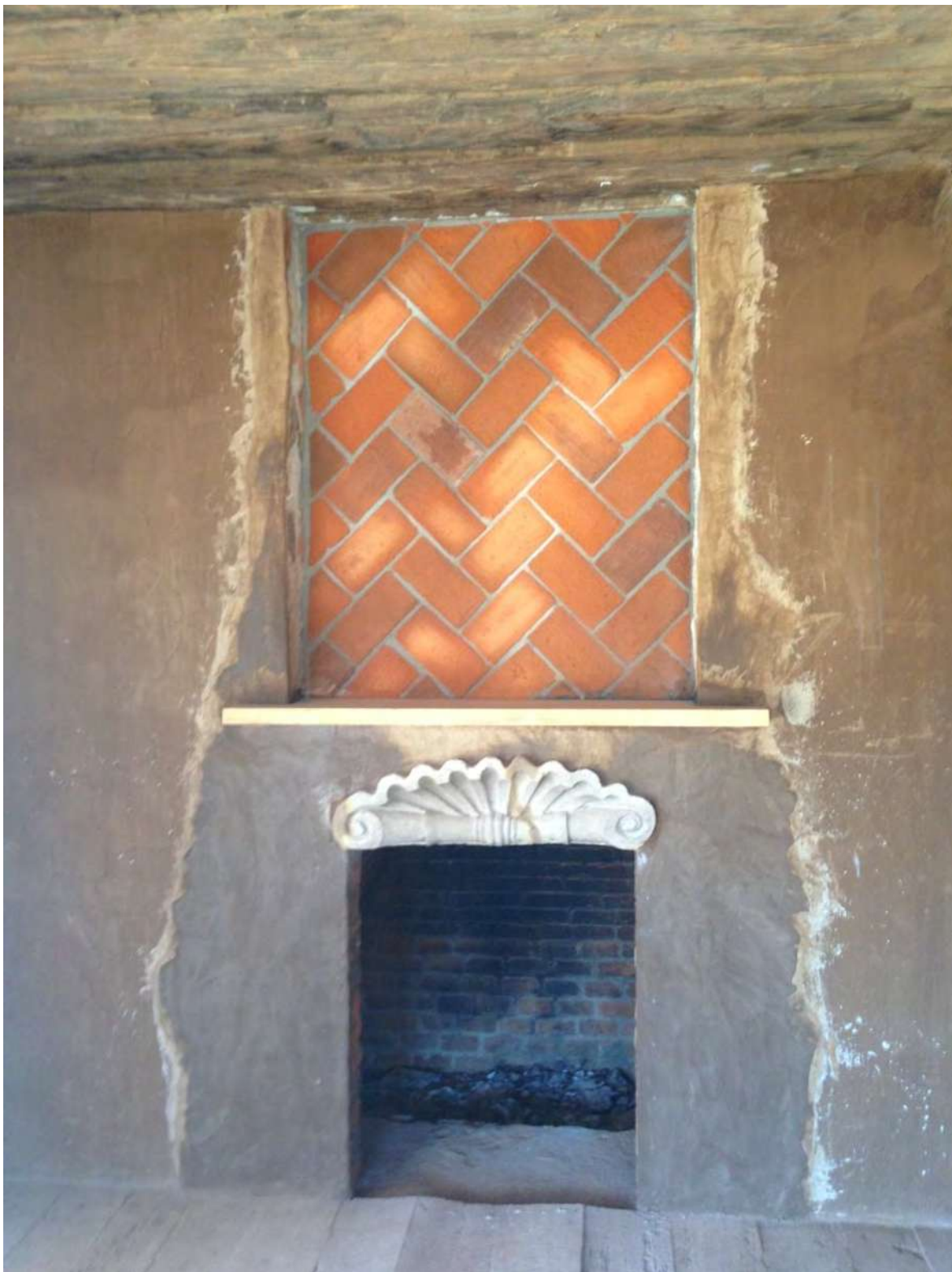
fotografía: Francisco López (2013), forjado de chimenea, Ichupio, Mx.
