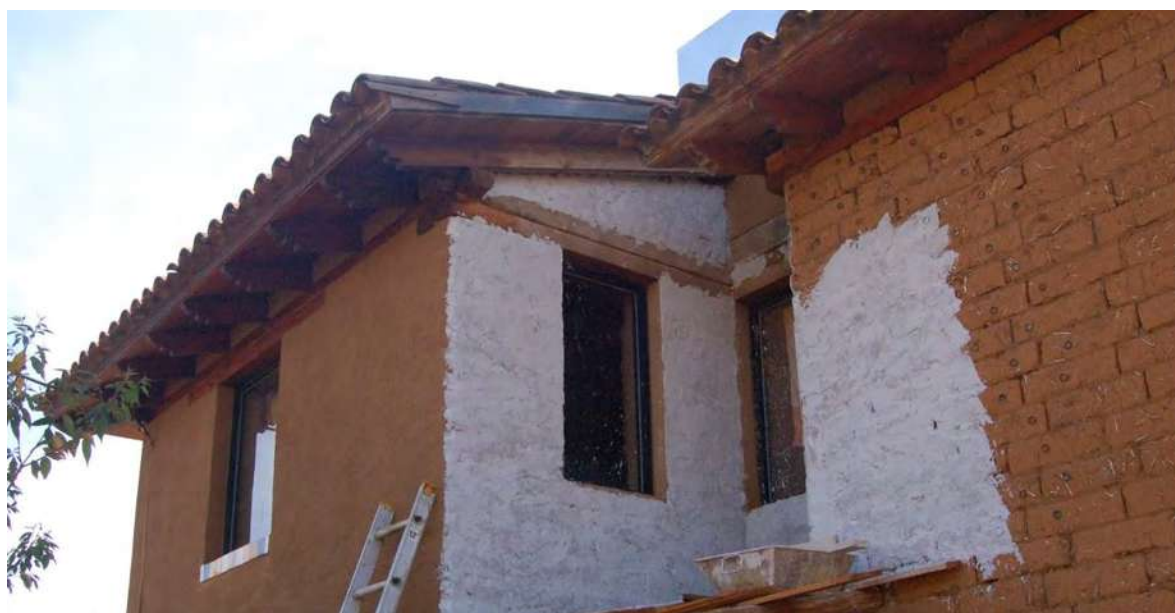
fotografía: Holger Hieronimi (2005), repellado natural con cal-arena, Erongarícuaro, Mx.
