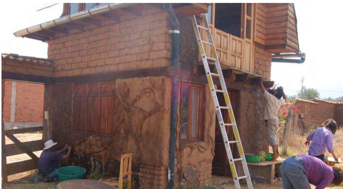
fotografía: Holger Hieronimi (2007), repellado natural con cob, Erongarícuaro, Mx.
