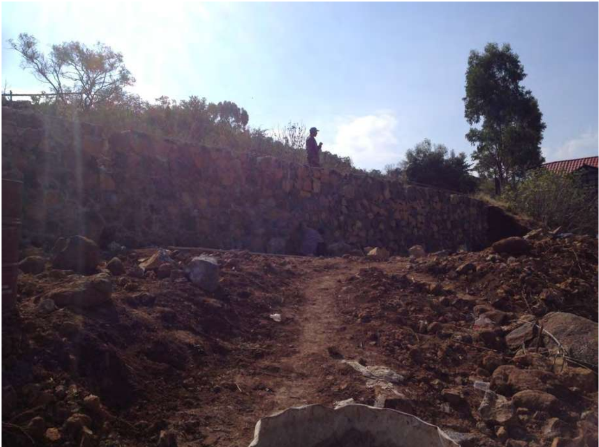
fotografía: Francisco López (2012), muros de contención de piedra braza en el perímetro del terreno, Ichupio, Mx.
