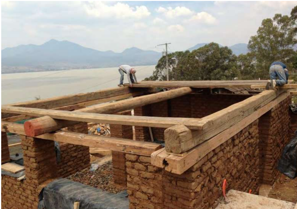
fotografía: Francisco López (2013), montaje de la troje con el sistema constructivo original, Ichupio, Mx.
