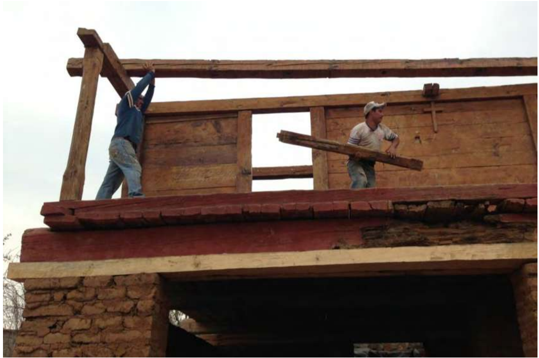
fotografía: Francisco López (2013), reubicación y montaje de troje, Ichupio, Mx.
