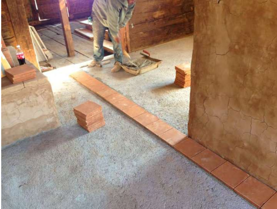
fotografía: Francisco López (2013), firme de concreto y loseta de barro recocido, Ichupio, Mx.
