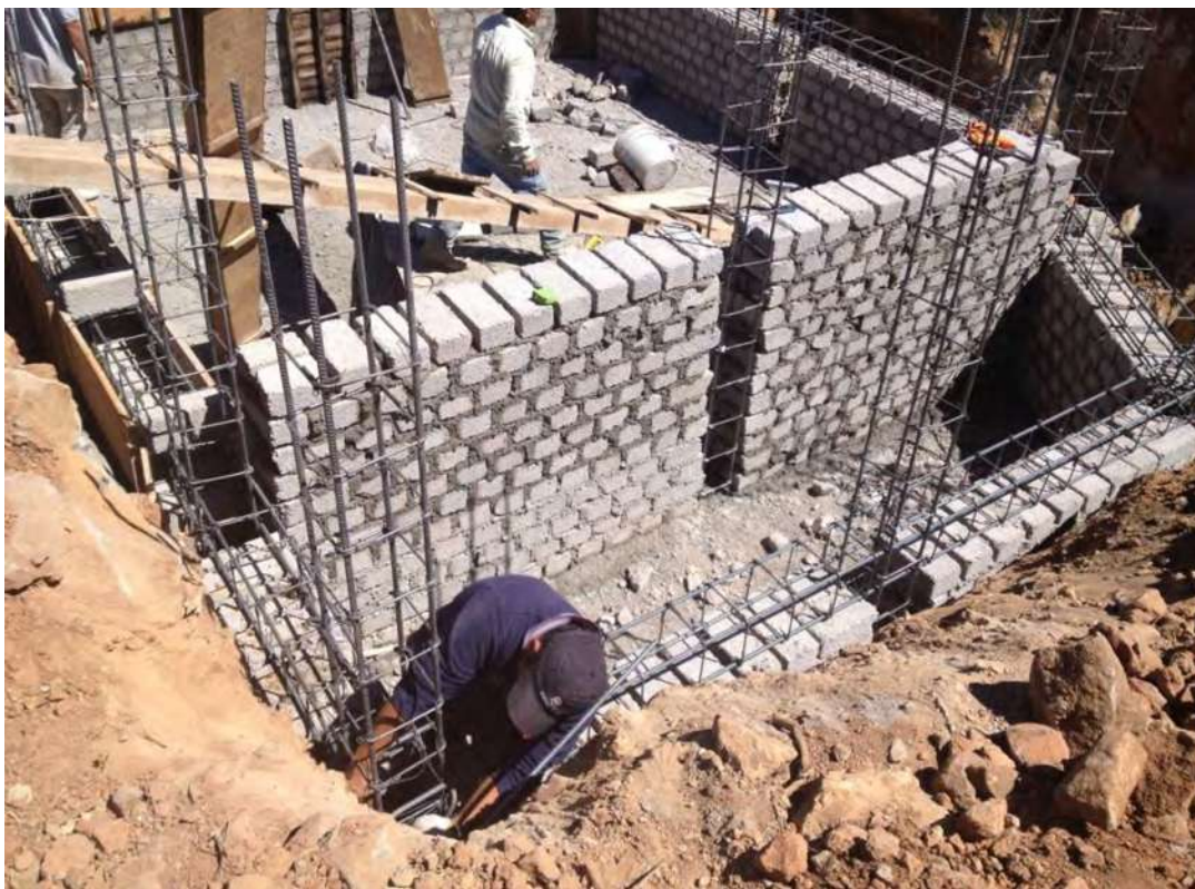
fotografía: Francisco López (2012), construcción de cisterna, Ichupio, Mx.
