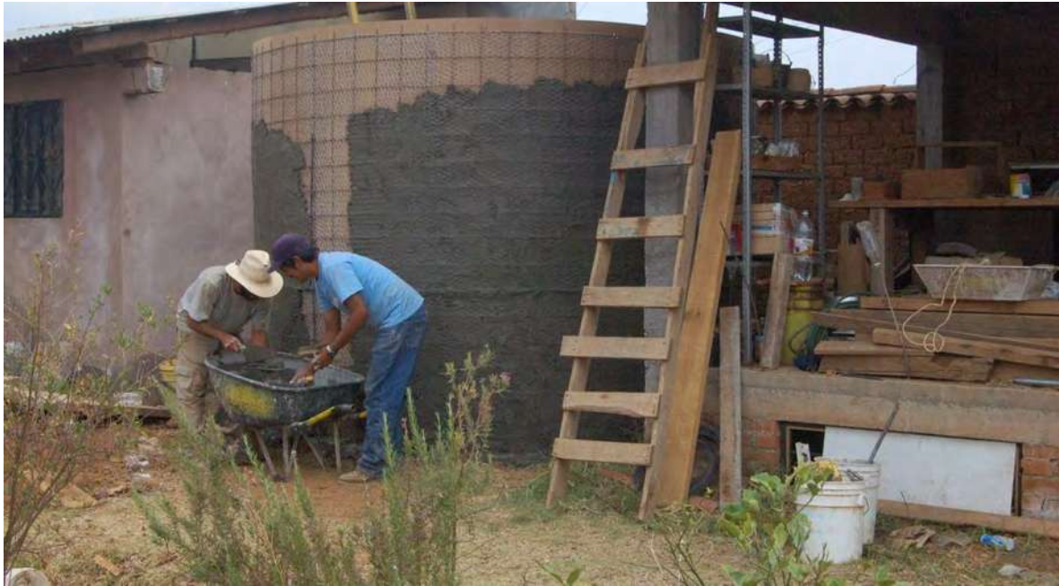
fotografía: Holger Hieronimi (2007), proceso constructivo de cisterna de ferrocemento en Erongarícuaro, Mx.
