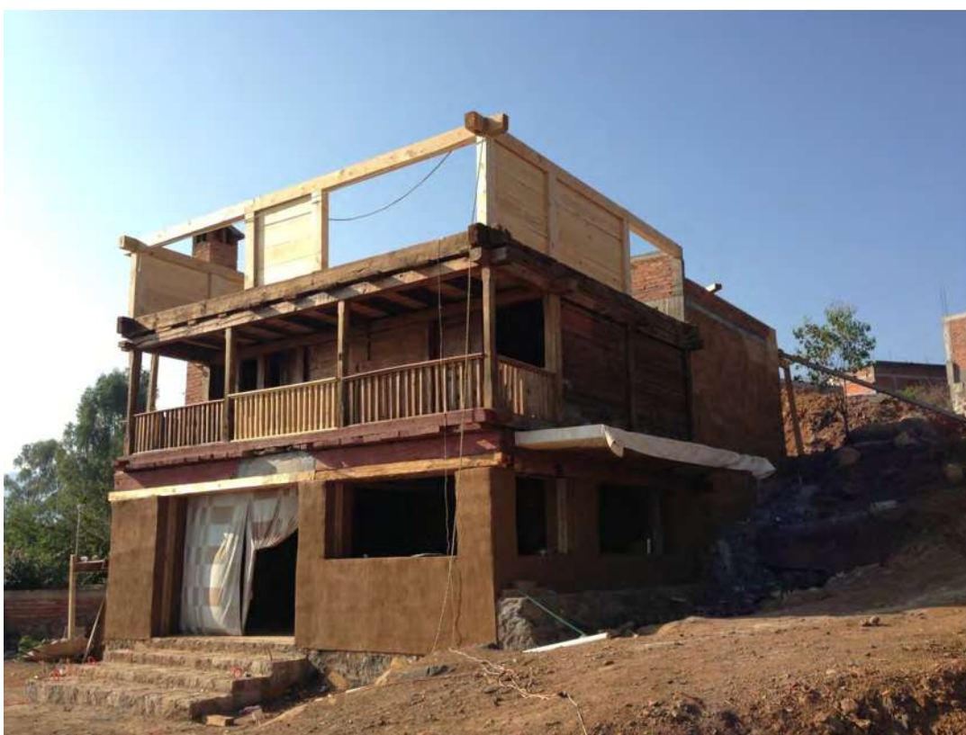
fotografía: Francisco López (2013), montaje de la troje y adaptación de altura superior, Ichupio, Mx.
