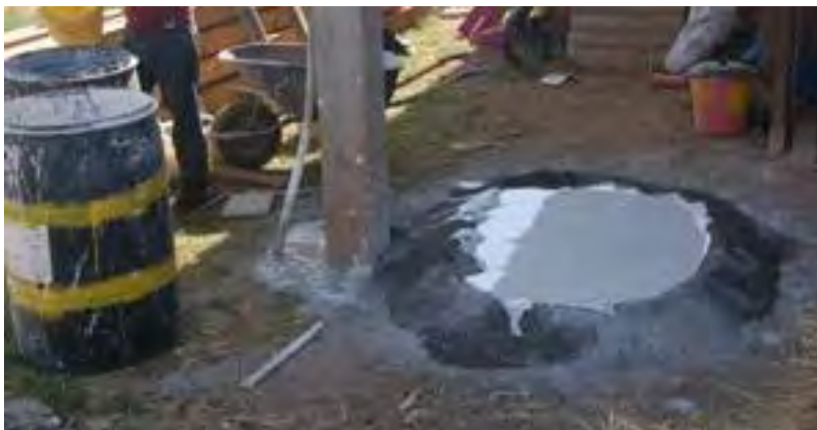
fotografía: Holger Hieronimi (2005), fabricación de mezcla para repellar, Erongarícuaro, Mx.
