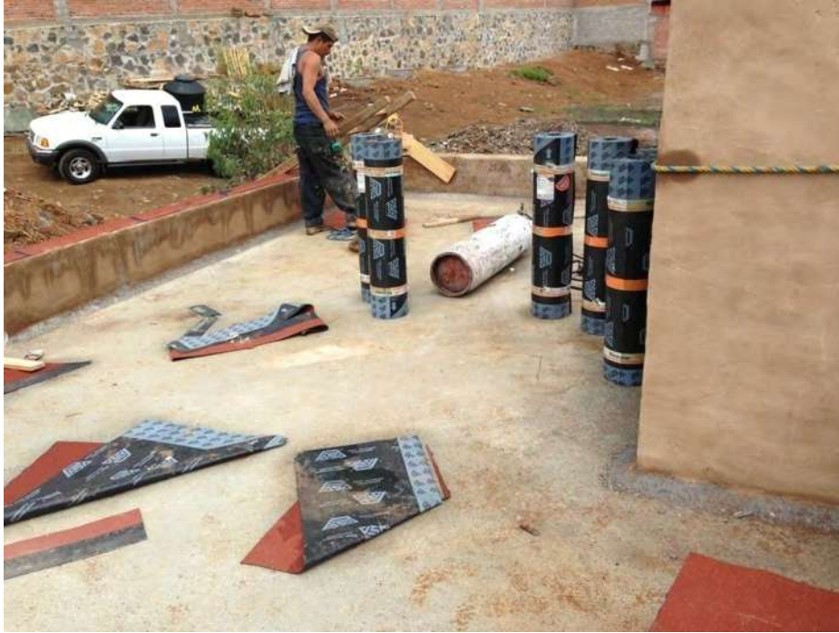
fotografía: Francisco López (2013), impermeabilizante prefabricado, Ichupio, Mx.
