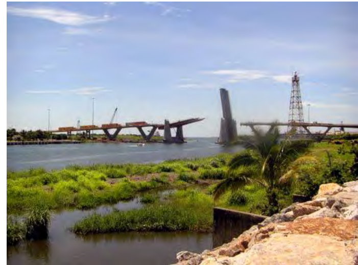
Fig 4. Vista previa a la construcción del Malecón de la cultura y las artes
