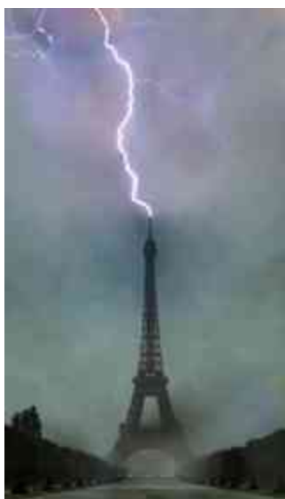
Ilustración 59: Pararrayos en la torre Eiffel. http://img269.imageshack.us/img269/7613/47370327.jpg
