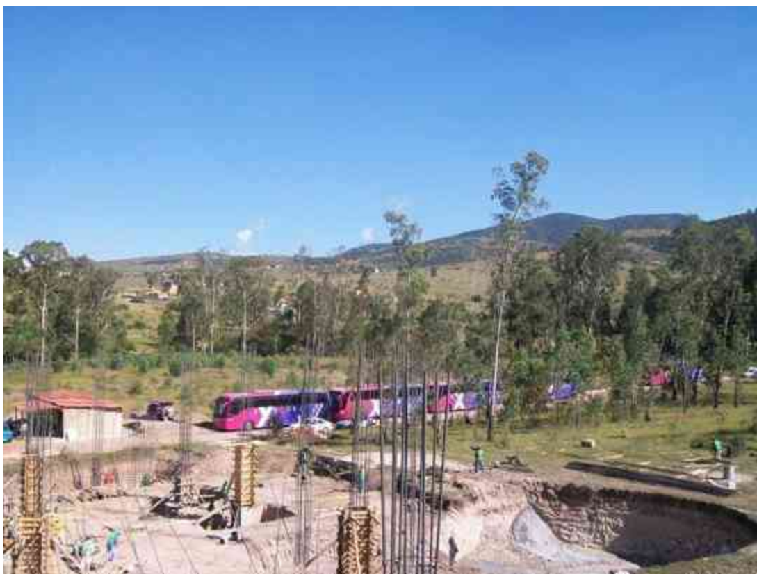
Ilustración 12 Excavación para cimentación de la ENES localizada al norte del terreno, donde se muestra claramente la profundidad a la que se encuentra la cantera. Foto de Jonathan Mata H. Noviembre 2012
