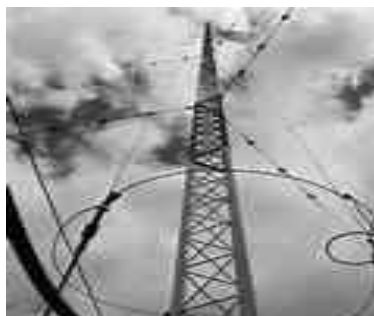
Ilustración 48: Antena de radio am. http://prelaturademoyobamba.files.wordpress.com/2010/06/antena-am-ccse.jpg
