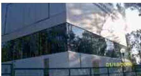
Ilustración 33 Edificio CIB IMSS, acabados en paneles de polímeros y cristal: por Jonathan Mata
