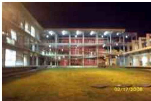
Ilustración 32: Edificio CIGA UNAM uso de acero como elemento estructural y acabado: por Jonathan Mata
