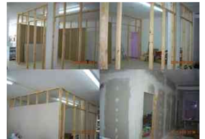
Figura 32.3 muro divisorio de tablaroca
