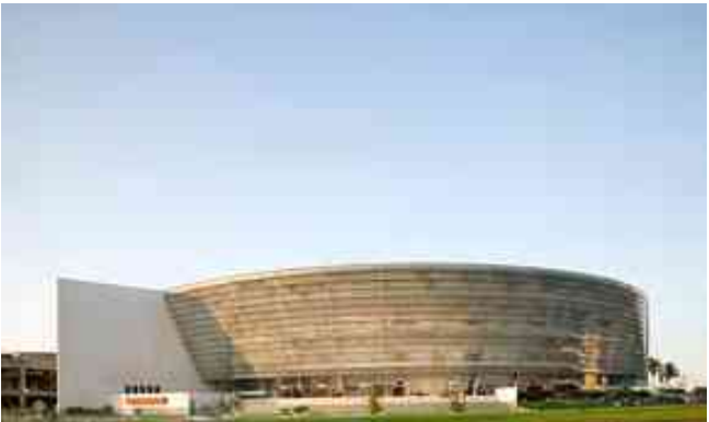
Figura 3.2 Fachada principal del Foro Imperial
