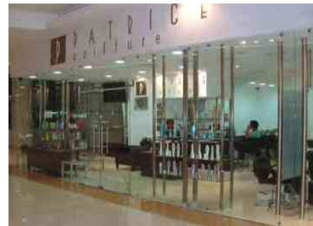
Figura 32.2 muro divisorio de cancelería
