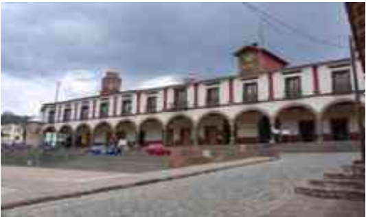
Figura 4.2 fachada de la presidencia municipal
