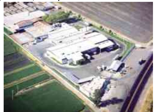
Foto No.7: Vista aérea de la planta DELTA S.A. de C.V. Fuente: Carlos Hahn Ramírez.
