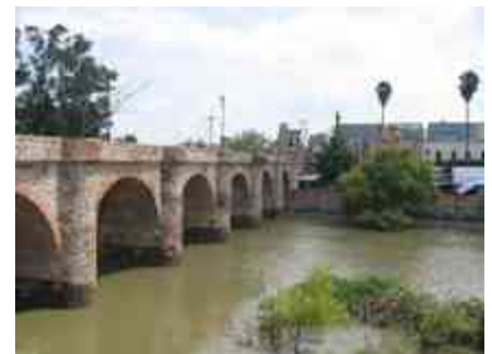
Imagen No.13: Puente Cavadas en La piedad, Michoacán.
