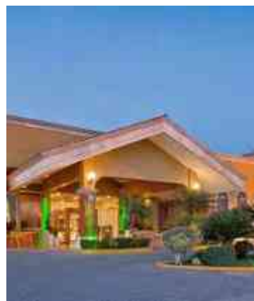
Imagen No.28: Acceso principal al HOTEL HOLLIDAY INN.
