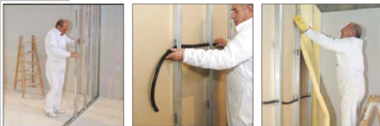
Ilustración 36.- Procedimiento de colocación de fibra de vidrio, tomado de la página www.ursa.es
