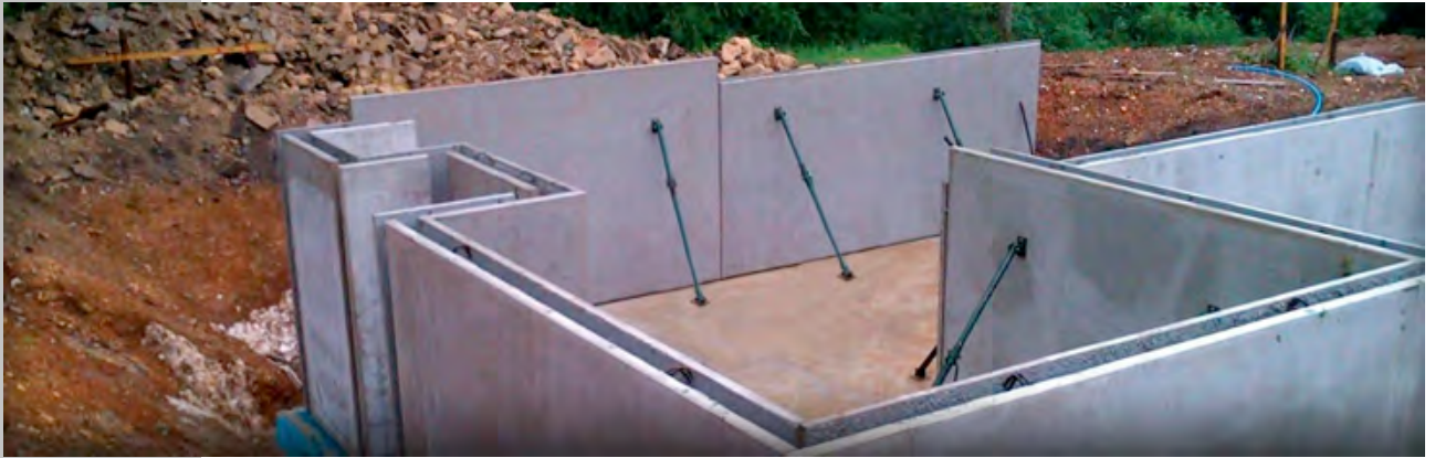
Ilustración 34.- Muro doble tomado de la página http://img.archiexpo.es/images_ae/photo-g/muros-dobles-prefabricados-hormigon-armado-69765-4211215.jpg
