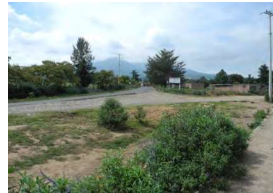
Imagen 39: Carretera Patamban – Tangancícuaro tomada por: Francisco Reyes - 8 de noviembre del 2012
