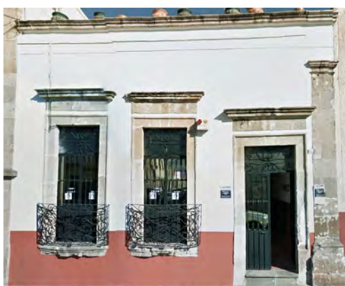
Fachada (IMICH estado actual)
