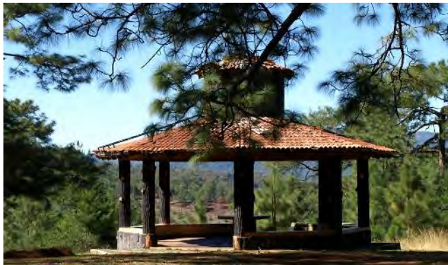
Parque Ecológico Cerro Hueco kiosco.
