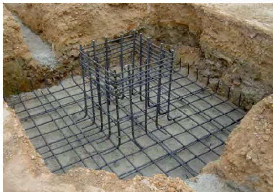
Armado de una zapata aislada
