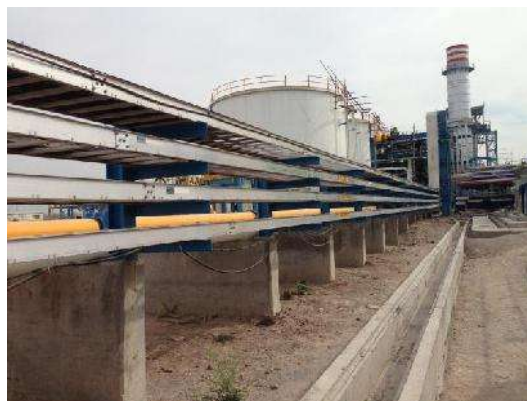
Fig. 67 Colocación de Charolas Eléctricas Foto del Proyecto Salamanca
