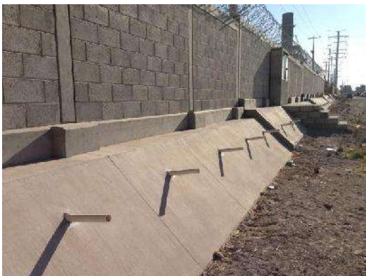
Fig. 18 Barda Perimetral Foto del Proyecto Salamanca
