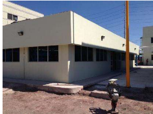
Fig. 25 Edificio Capacitación Foto del Proyecto Salamanca
