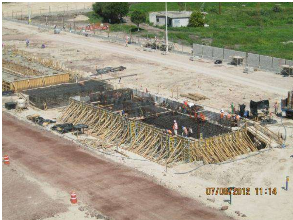
Fig. 15 Cimentación Isla de Potencia Foto tomada en sitio
