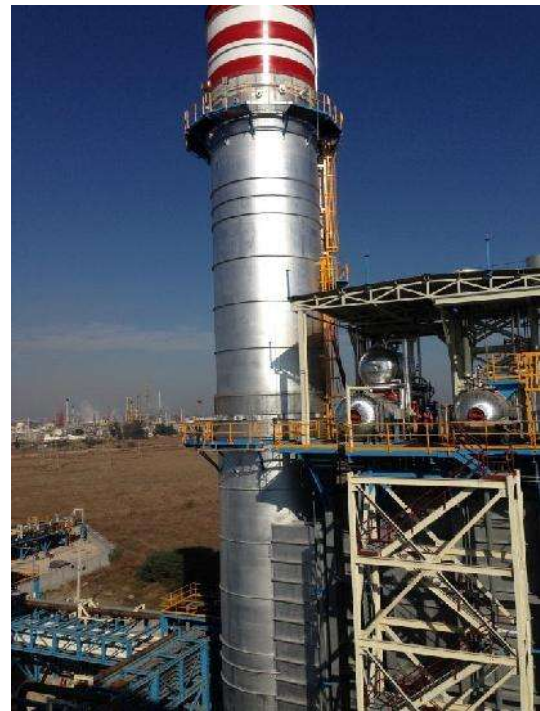
Fig. 60 Aplicación Recubrimiento Caldera Unidad 3 Foto del Proyecto Salamanca
