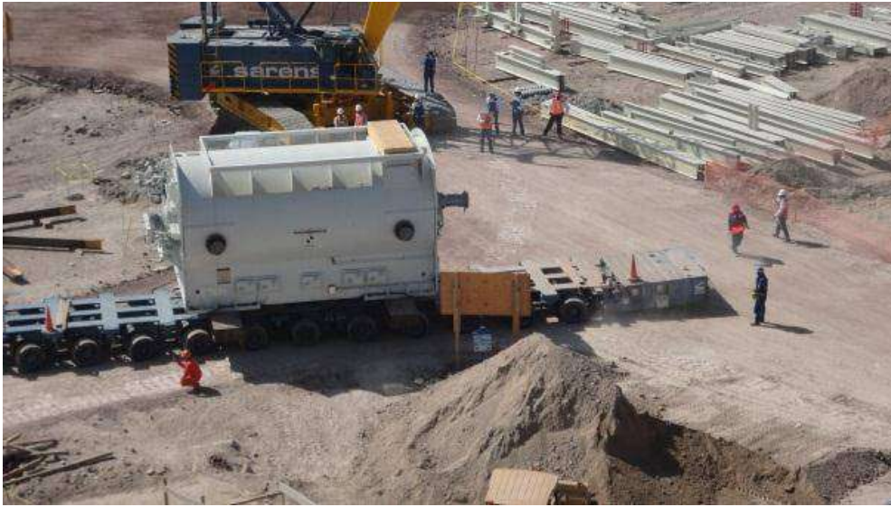
Fig. 42 Transporte Generador Unidad 3 Foto del Proyecto Salamanca
