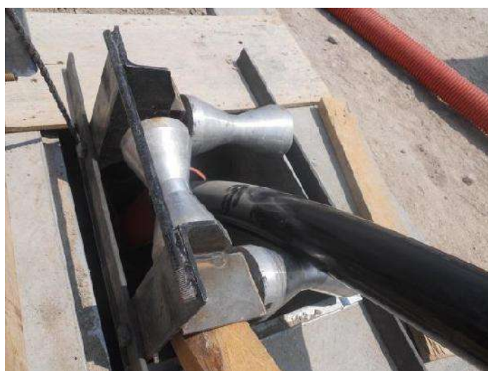
Fig. 78 Instalación de Cables de Potencia en Galerías Subestación Foto del Proyecto Salamanca
