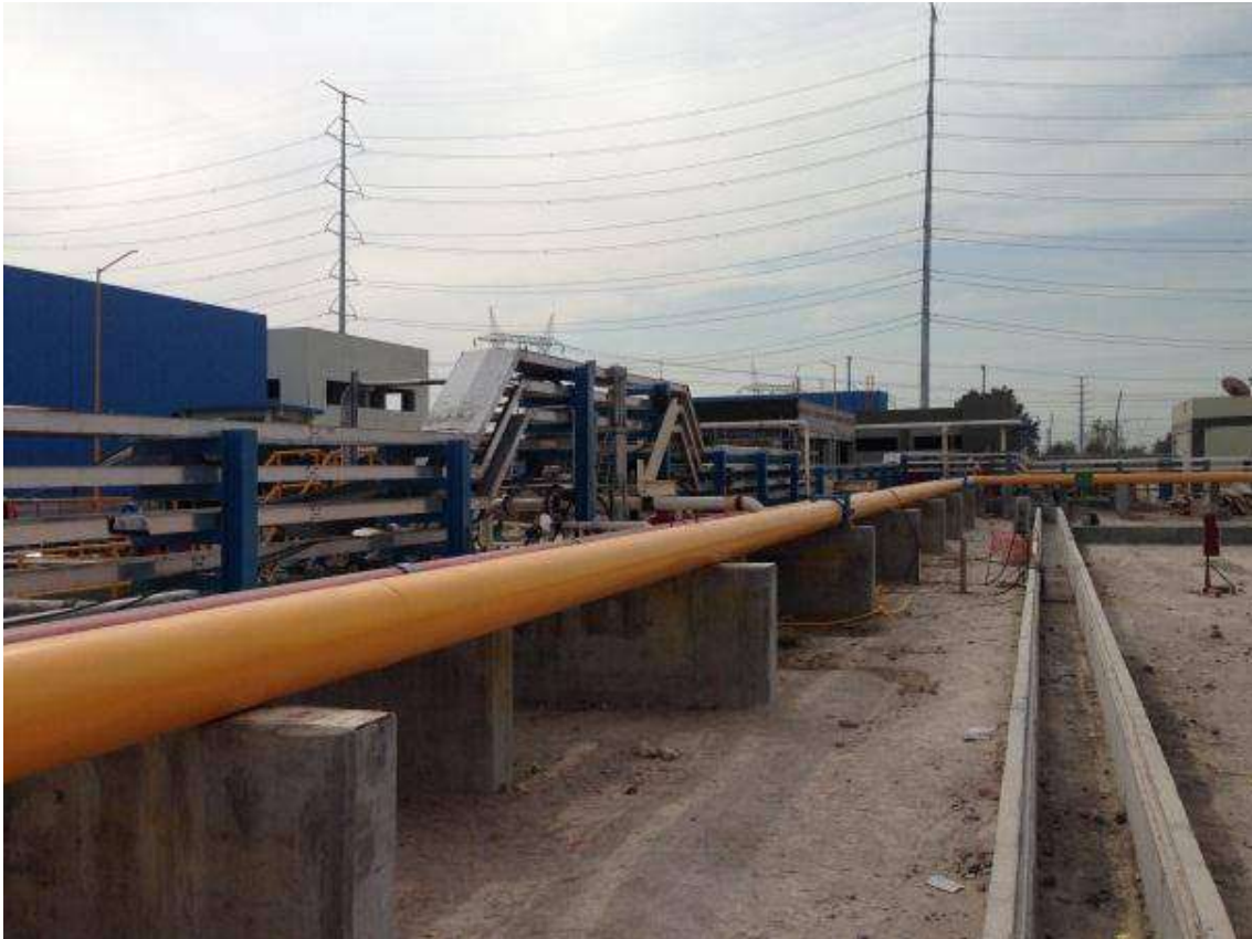
Fig. 52 Línea de Gas Foto del Proyecto Salamanca
