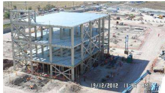
Fig. 31 Edificio Electrico Fijación Losa Acero Foto del Proyecto Salamanca
