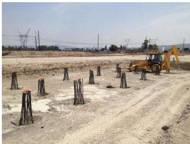
Fig. 10 Pilotaje Isla de Potencia Foto del Proyecto Salamanca
