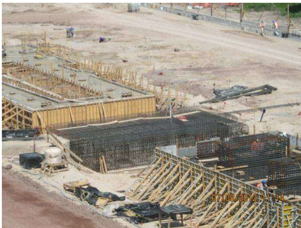
Fig. 14 Cimentación Isla de Potencia Foto del Proyecto Salamanca
