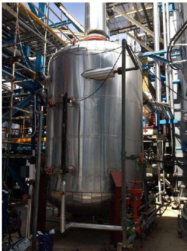
Fig. 64 Colocación de Aislamiento en Equipos Foto del Proyecto Salamanca
