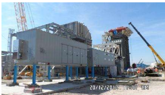
Fig. 34 Montaje Estructura Soportes Foto del Proyecto Salamanca
