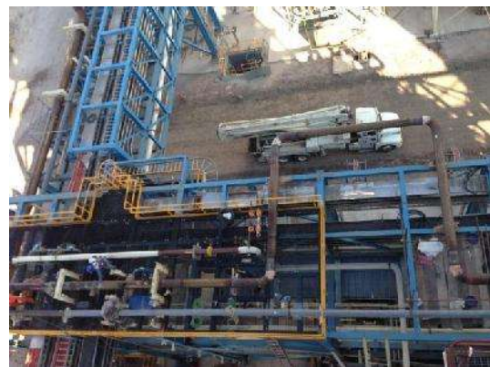
Fig. 35 Montaje Estructura Soportes Foto del Proyecto Salamanca
