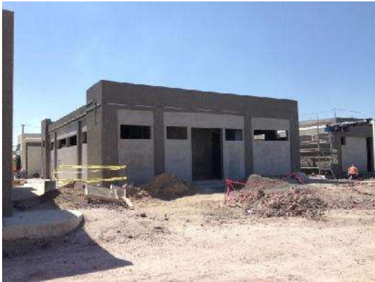
Fig. 24 Edificio Laboratorio Químico Ambiental Foto del Proyecto Salamanca
