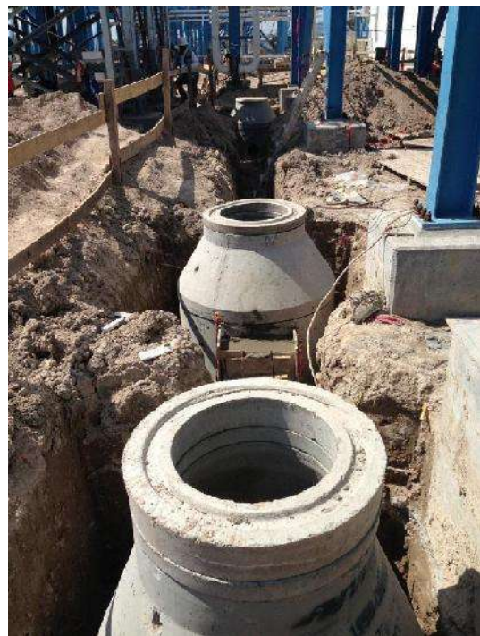
Fig. 37 Montaje Pozos de Registro Foto del Proyecto Salamanca
