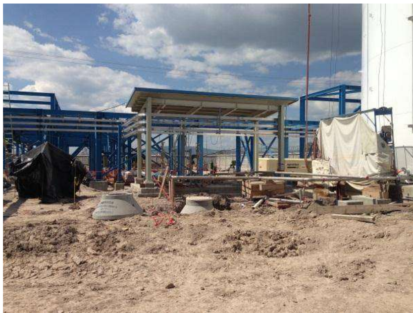
Fig. 38 Montaje Pozos de Registro Redes Enterradas Foto del Proyecto Salamanca
