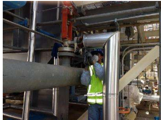
Fig. 62 Colocación de Aislamiento en Tuberías Foto del Proyecto Salamanca
