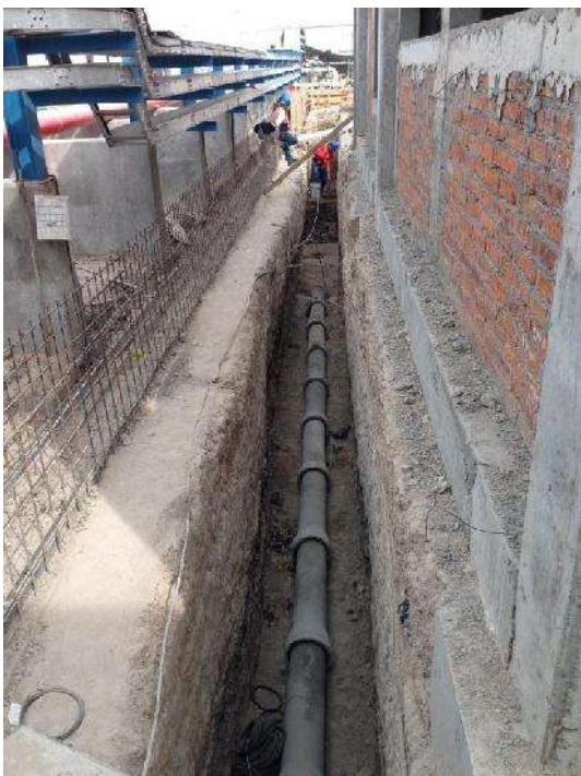
Fig. 36 Montaje Red de Proceso Foto del Proyecto Salamanca
