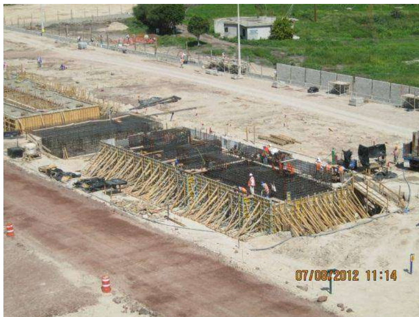
Fig. 13 Cimentación Isla de Potencia Foto del Proyecto Salamanca
