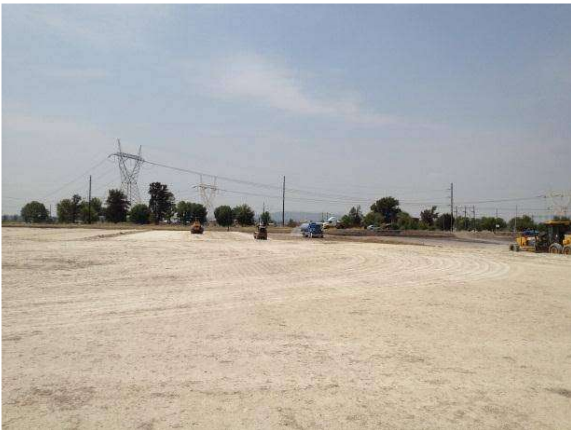
Fig. 9 Explanación del terreno Foto del Proyecto Salamanca
