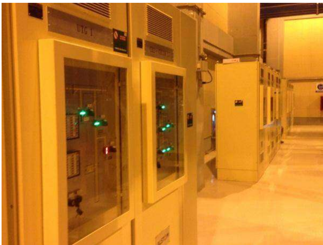
Fig. 72 Montaje de Gabinetes Eléctricos Foto del Proyecto Salamanca
