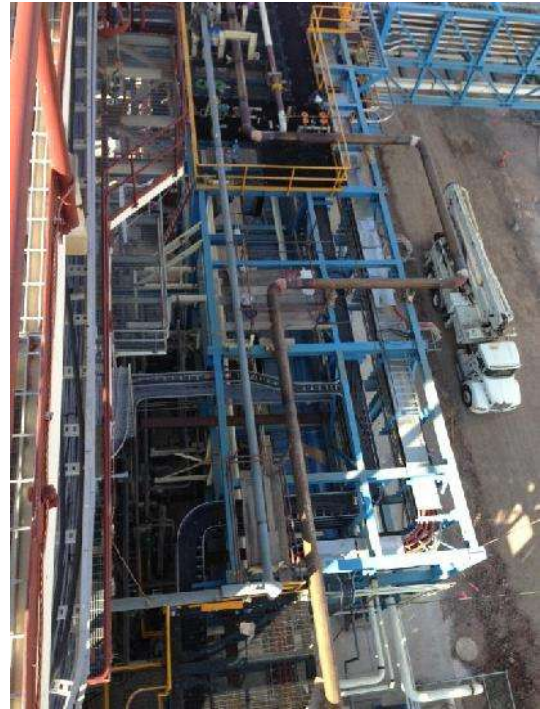
Fig. 47 Montaje de Tubería Foto del Proyecto Salamanca
