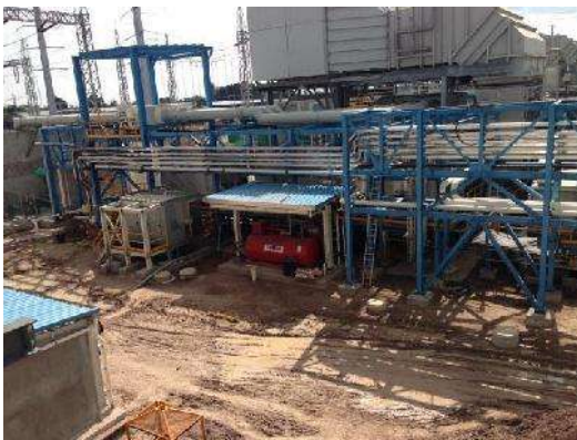
Fig. 46 Montaje de Tubería Foto del Proyecto Salamanca
