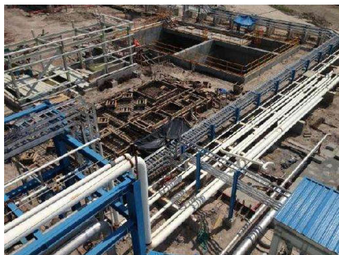
Fig. 48 Montaje de Tubería Foto del Proyecto Salamanca
