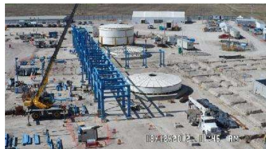
Fig. 33 Montaje Estructura Menor Foto del Proyecto Salamanca
