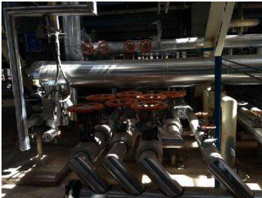
Fig. 61 Colocación de Aislamiento en Tuberías Foto del Proyecto Salamanca
