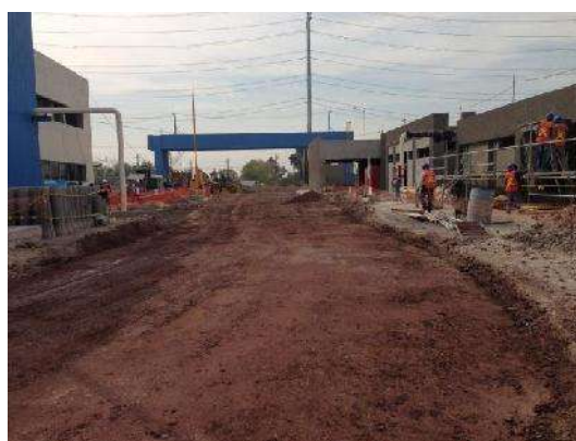
Fig. 29 Control de Acceso Foto del Proyecto Salamanca
