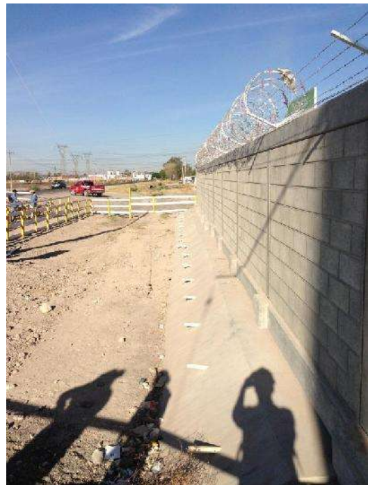
Fig. 19 Barda Perimetral Foto del Proyecto Salamanca
