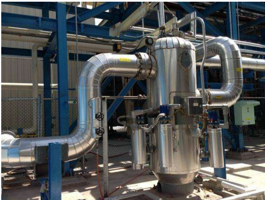
Fig. 63 Colocación de Aislamiento en Equipos Foto del Proyecto Salamanca
