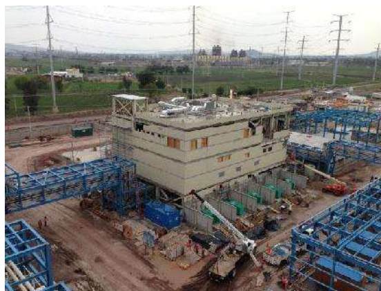
Fig. 26 Edificio Electrico Foto del Proyecto Salamanca
