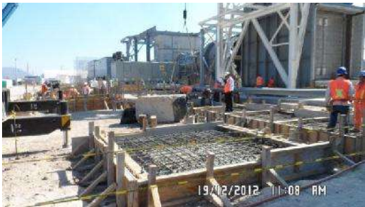
Fig. 30 Cimentaciones Auxiliares Foto del Proyecto Salamanca
