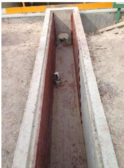
Fig. 39 Recubrimiento Trincheras, Sistema 54 Foto del Proyecto Salamanca
