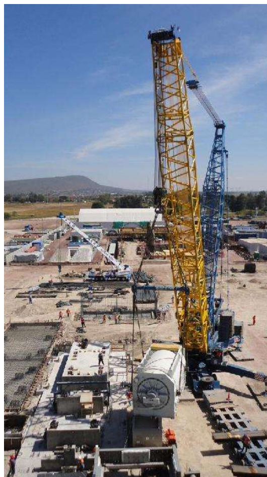
Fig. 41 Montaje Generador Unidad 3 Foto del Proyecto Salamanca
