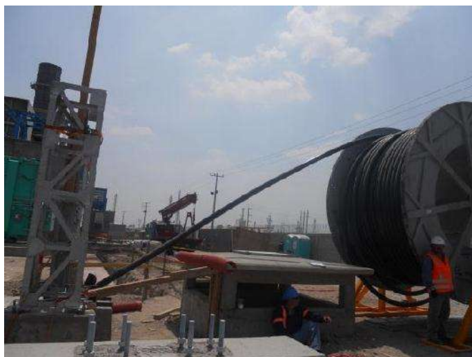
Fig. 77 Instalación de Cables de Potencia en Galerías Subestación Foto del Proyecto Salamanca
