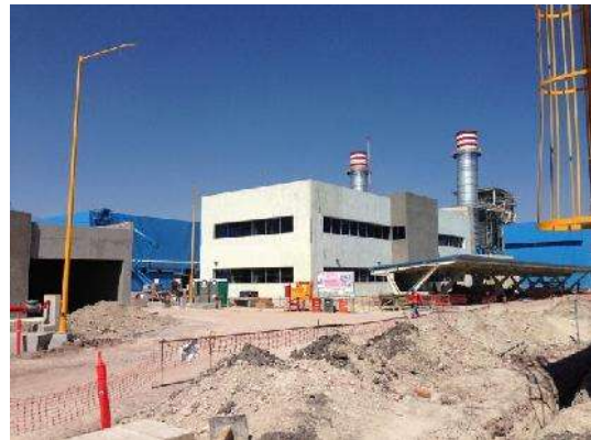
Fig. 23 Edificio Oficinas Foto del Proyecto Salamanca
