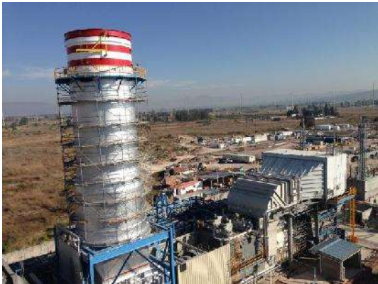
Fig. 59 Aplicación Recubrimiento Caldera Unidad 3 Foto del Proyecto Salamanca
