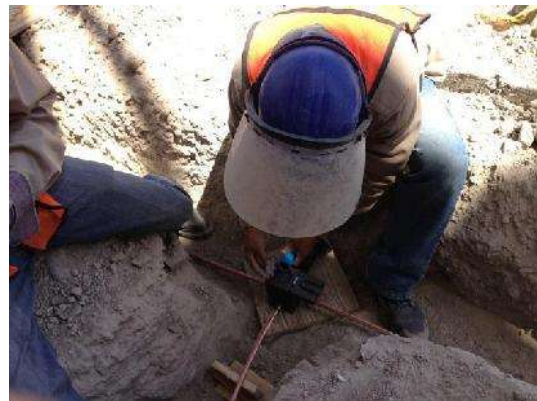
Fig. 66 Red de Tierras Ejecución de Soldadura Foto del Proyecto Salamanca
