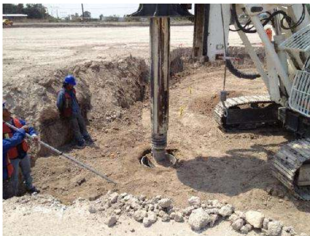
Fig. 11 Perforación pilas Foto del proyecto Salamanca
