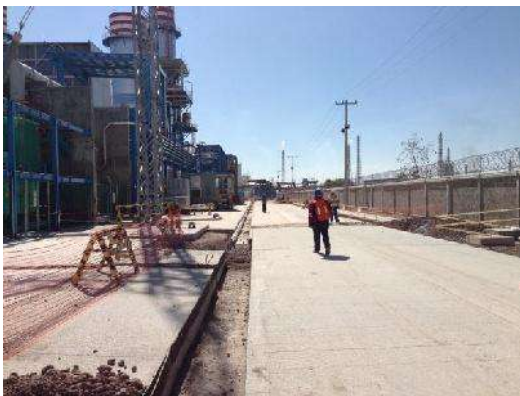
Fig. 27 Vialidad lado Norte Unidad 3 Foto del Proyecto Salamanca
