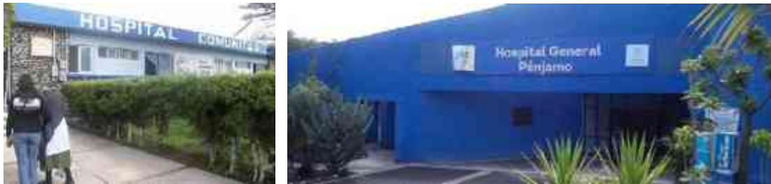
Fig. 48-49, Hospital Comunitario y Hospital General de Pénjamo Guanajuato. Foto, VVO.
