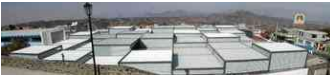
Fig. 64. Vista de la techumbre del Mercado San Pablo Oztotepec. http://www.podiomx.com/2012/07/mercado-san-pablo-oztotepec-por-taller_27.html
