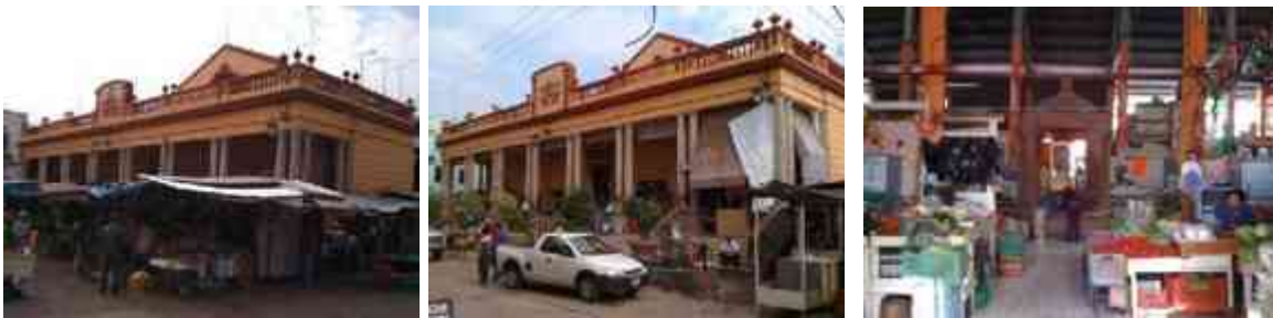
Fig. 11-13, Fachadas e interior del mercado municipal de Pénjamo Guanajuato, foto, VVO.
