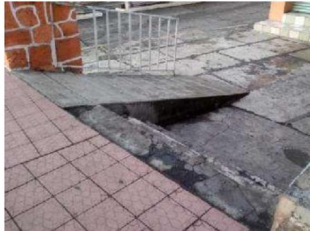
escalinata de acceso en la parte sur, mientras que en el costado oeste es el acceso para personas discapacitadas como se muestra en la fotografía 31, donde apreciamos la rampa con pendiente mayor al 6%.
