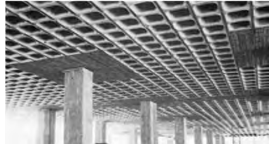
Losa reticular y columnas de concreto armado.
