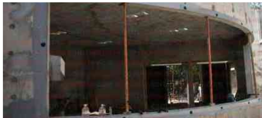
Foto 35. Construcción elevada del estanque panorámico en el acuario de Mazatlán.
