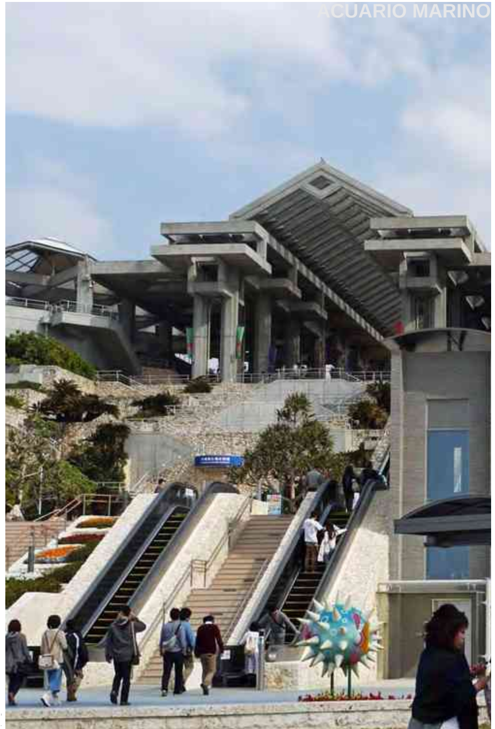
Foto 28: Acceso poniente del acuario Chiriquí, apreciando la escala y altura del conjunto.
