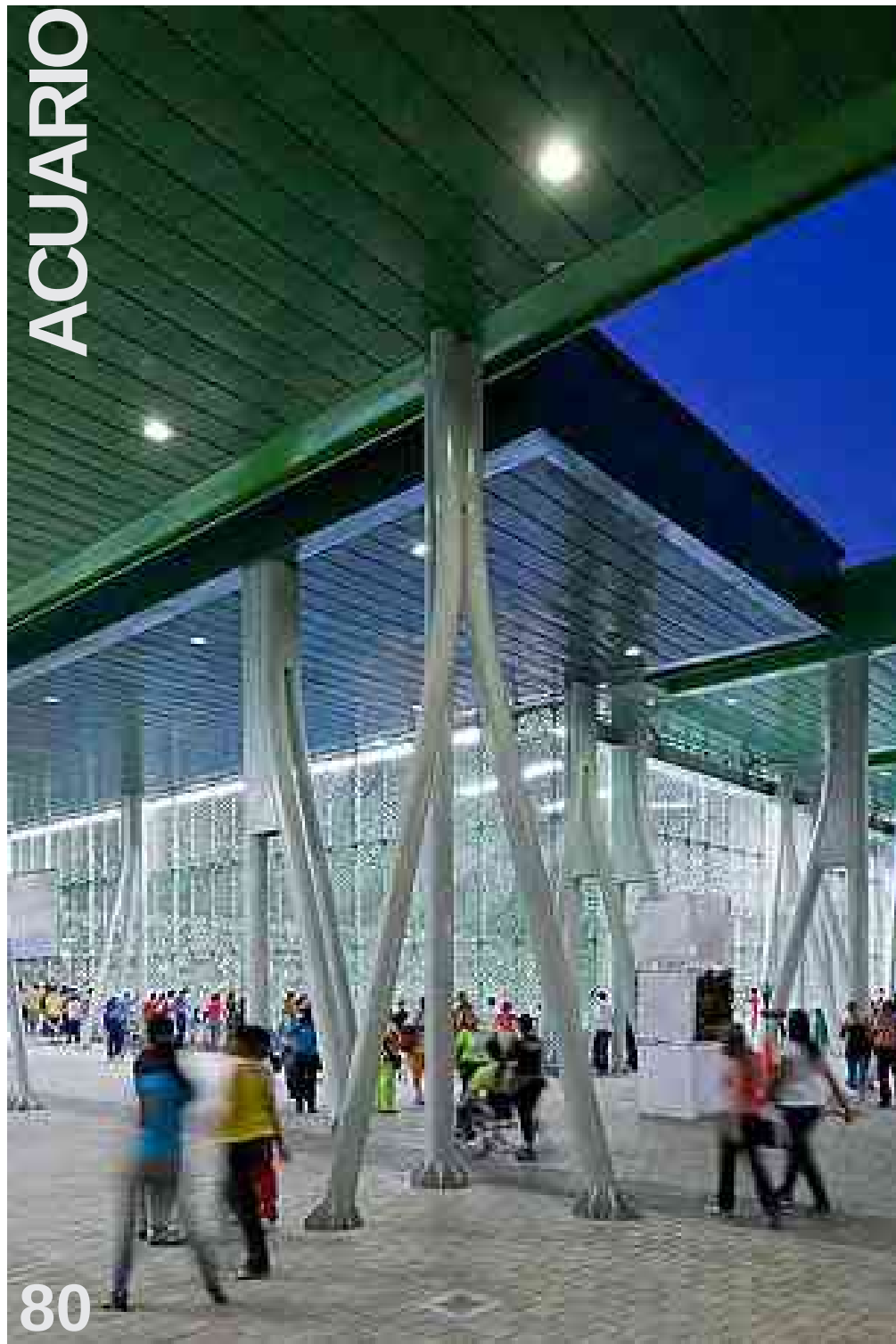
Foto 44: Estructura metálica manejando cada "listón" como ente independiente entre sí.
