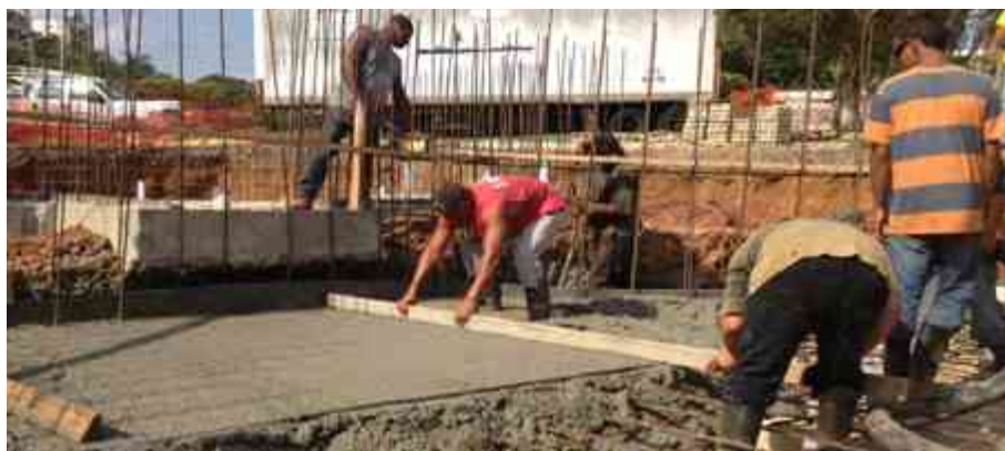
Foto 34. Construcción subterránea del estanque de arrecife de coral en el acuario del Zoológico de Guadalajara.
