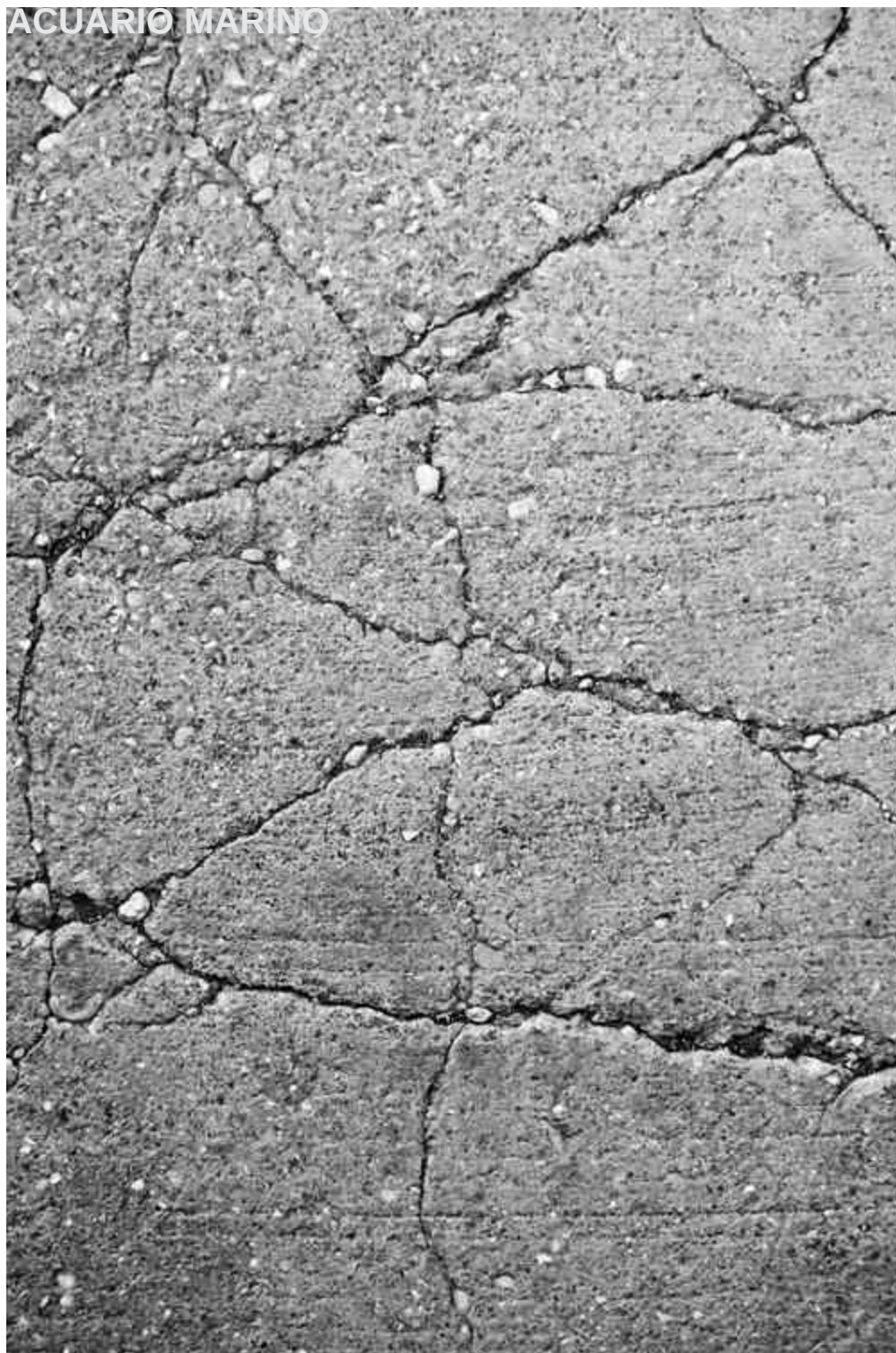
Foto 36: Grietas y fisuras en el concreto que pueden presentarse al momento de la construcción del estanque.
