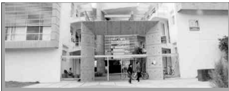
Imagen 5.- Nuevo edificio de Ingeniería Eléctrica.
