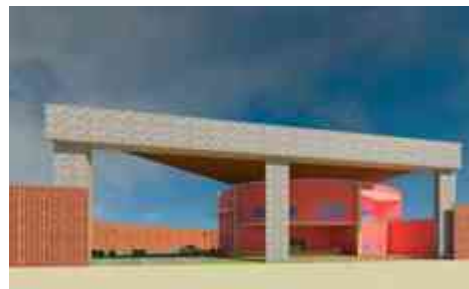
Lamina 22 Fachada principal Centro de Justicia. Fuente: Bianey Contreras Cortés
