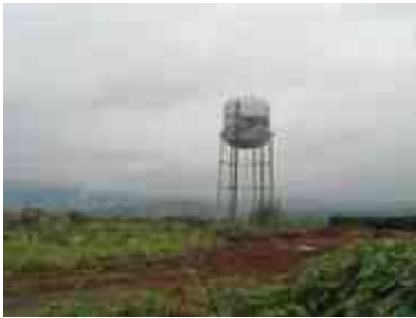
Imagen 4, Tanque agua potable fuente: bianey contreras cortés
