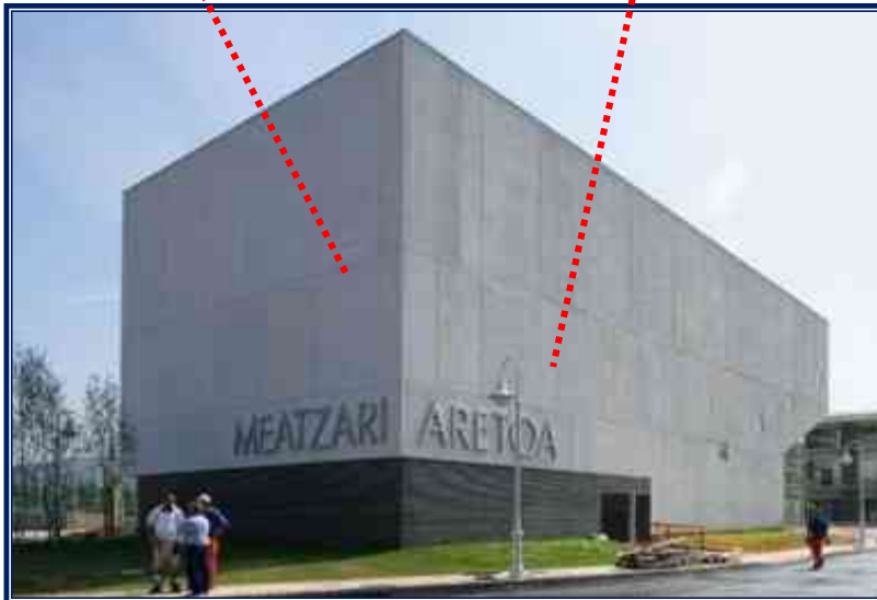
Imagen 35. Auditorio y Edificio Polivalente, Muskiz – España, VIRAI Arquitectos. http://www.arquitour.com/auditorio-y-edificio-polivalente-virai-arquitectos/2009
