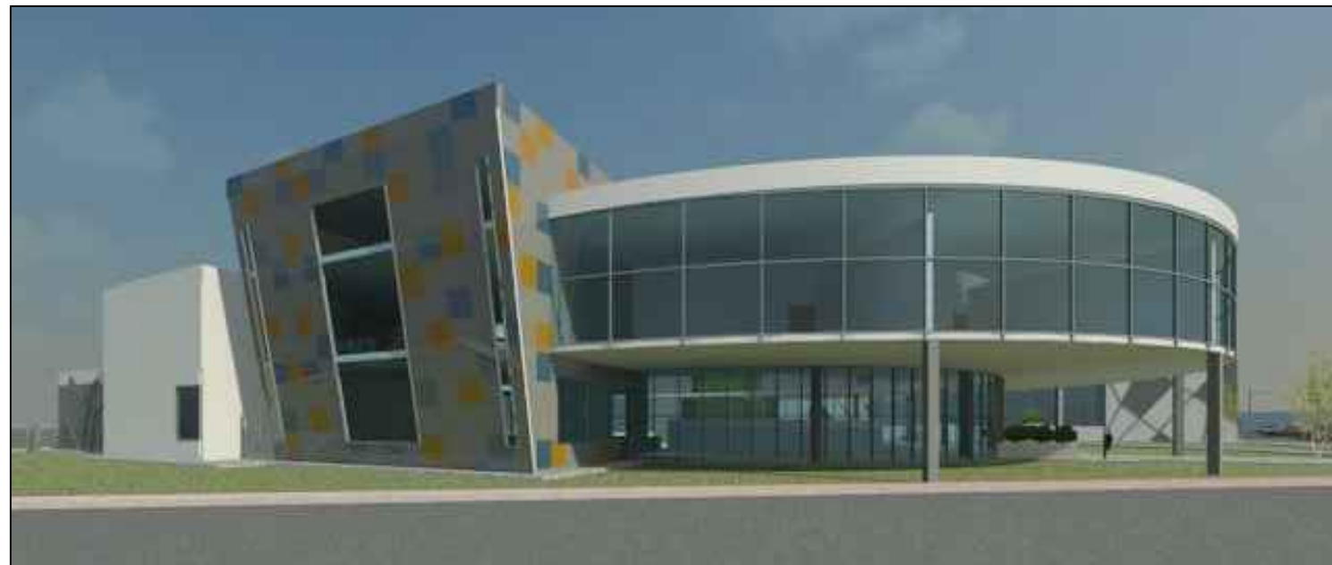
vista sur de la ESCUELA
