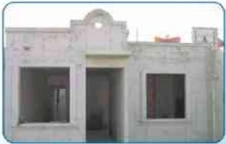
Con el sistema **FORSAalum** es posible construir frontones curvos, rectos o en diferentes configuraciones. Negativos en acero, circulares o rectos, son fijados a las formaletas de muro de fachada como detalles para instalación posterior de prefabricados como gárgolas.
