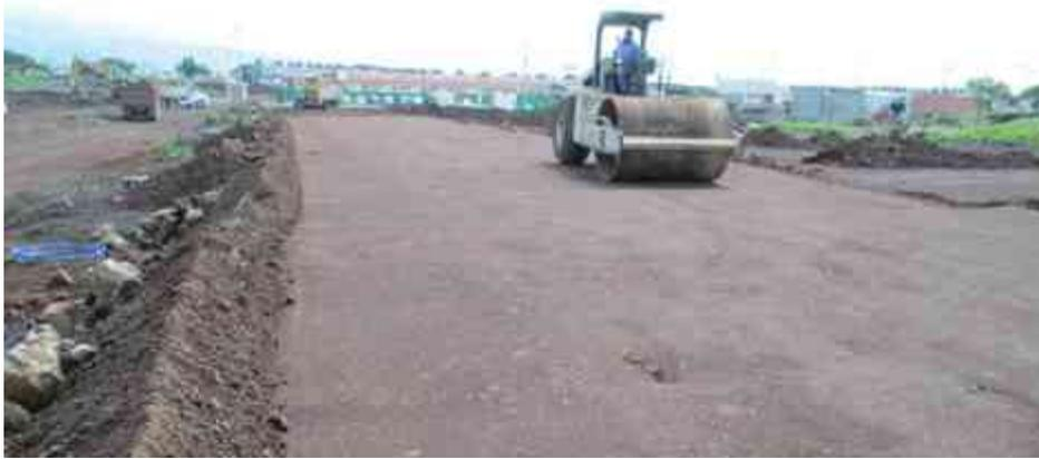
Figura 79: Compactación de Sub Base en plataforma de la Mza 62 calle Tordos
