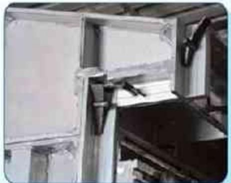
Con el ángulo exterior se logran diferentes tipos de ensambles verticales y horizontales entre piezas.
