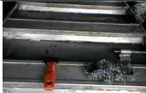
Una vez retirada la cimbra comienza nuevamente el trabajo de limpieza el cual se realiza manualmente utilizando espátulas y fibra metálica.
