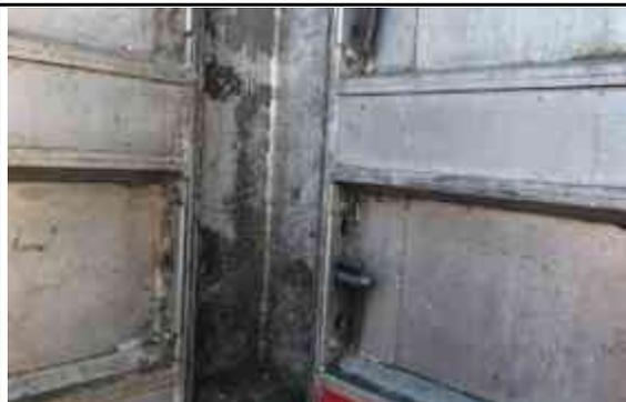
Los esquineros de muro son perfiles utilizados para onformar las esquinas internas a 90 grados con las formaletas de muro.
