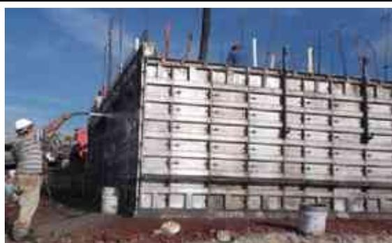
Durante el vaciado del concreto se debe lavar en su totalidad la cara externa de las formaletas con el proposito de retirar la lechada de concreto que se produce durante el colado.
