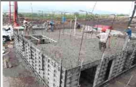
Una vez que se llenaron los muros se continua con el bombeo del concreto para losa, el volumen requerido para muros de planta baja es de 15 m<sup>3</sup> y para losa 8 m<sup>3</sup>.
