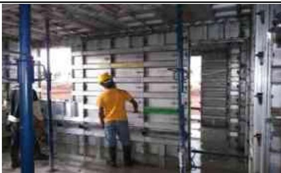
Durante el vaciado del concreto se debe verificar que el concreto llene completamente la sección de muros golpeando con martillo de goma.
