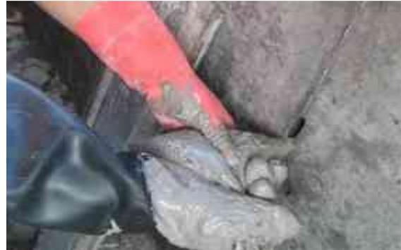
Los huecos generados por las corbatas se rellenan con mezcla hecha de cemento, mortero, marmolina, adhesivo para concreto y agua.
