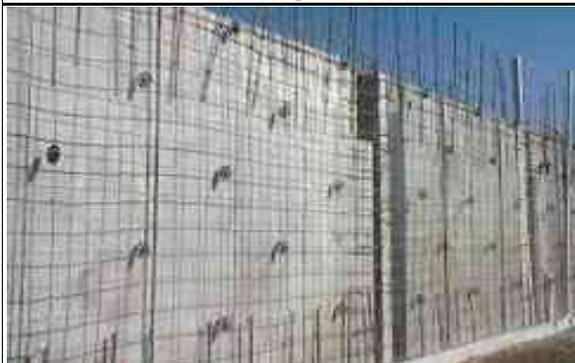
Para una correcta colocación de las formaletas de muro es conveniente comenzar de los extremos y hacia el centro de cada tramo de muro.
