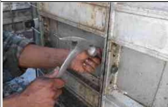
Para unir entre si las formaletas de muros se emplean accesorios de acero templado, asegurando su fijación con el uso del martillo.
