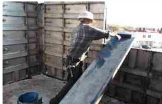
Una vez limpias se aplica una capa de desmoldante en la cara de contacto y los costados a cada formaleta para evitar adherencias de concreto y facilitar la descimbra.
