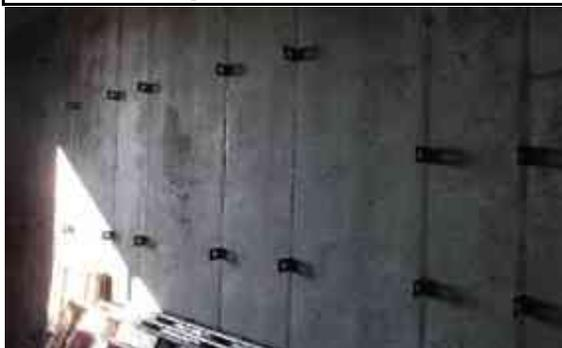
El proceso de descimbrado comienza por muros, quedando vidibles las puntas de corbatas de sujeción.
