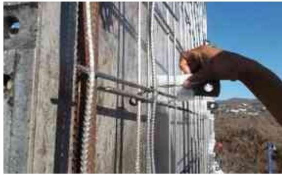
Para unir las formaletas de ambas caras del muro se colocan "corbatas" las cuales deben protegerse con fundas de bajo alfombra para facilitar su retiro durante el descimbrado.
