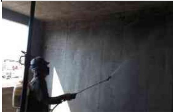
Inmediatamente despues de realizar el descimbrado se debe aplicar una capa de membrana de curado al concreto fresco para favorecer la conservación de humedad y logra alcanzar su resistencia.
