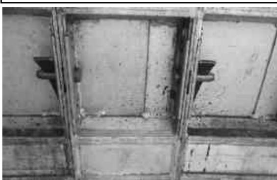
Los accesorios de sujeción básicos para la unión de formaletas de muros son: Perno, Cuña y Corbata
