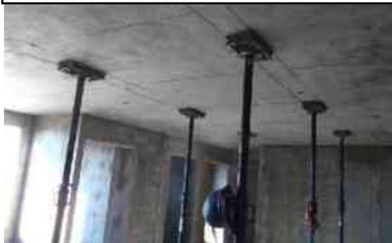
El apuntalamiento debe permanecer colocado hasta que el concreto de losa alcance la resistencia de proyecto.
