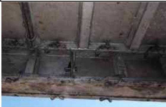
Para la union entre formaletas de muro con losa se utiliza otro accesorio de sujeción llamado pin grapa.
