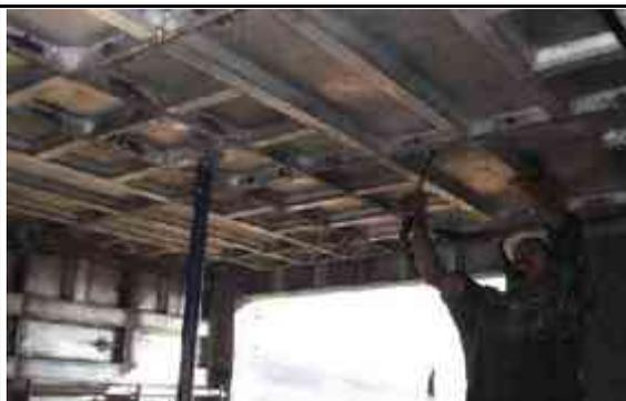
Para la colocación de cimbra de losa emplean los mismos criterios de mantenimiento y sujeción, adicionalmente se emplean puntales telescópicos que soportan y ayudan a nivelar la losa.
