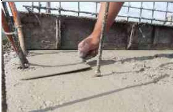
Con el empleo de escantillón y cuchara se verifican el espesor de losa que es de 10 cm en entrepiso y azotea.
