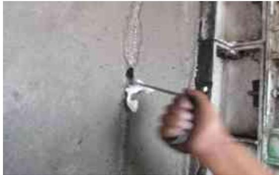
Una vez retiradas las fundas se extrae el bajo alfombra con la ayuda de un gancho metálico.
