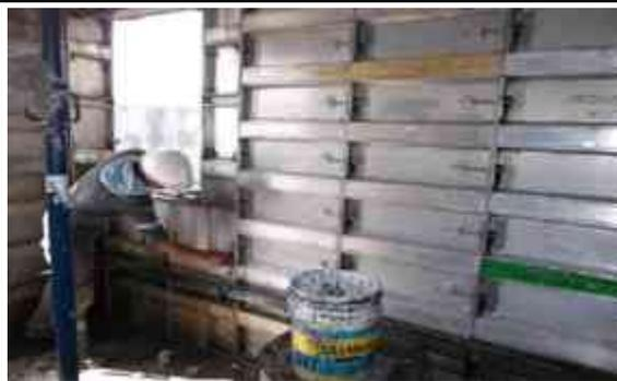
Previo al vaciado del concreto y como parte del mantenimiento preventivo diario se realiza limpieza con diesel y fibra metálica a las formaletas.
