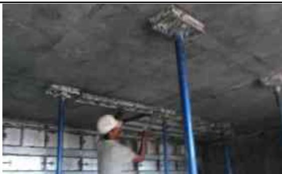
El retiro de las formaletas de losa se debe realizar respetando el apuntalamiento maestro colocado de acuerdo a la modulación indicada por el proveedor.
