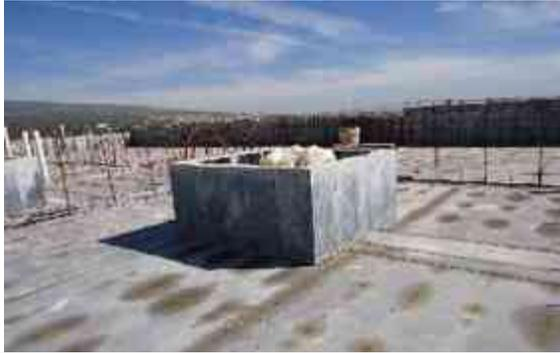
En los prototipos de dos niveles se contemplan domos para ventilación e iluminación de baño y cubo de escalera, estos domos se cuelan monolíticamente con la losa de azotea.
