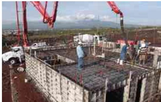
El concreto se comienza a vaciar de los muros centrales hacia los perimetrales y se emplean vibradores para concreto a gasolina y electricos, para faavorecer su correcto acomodo.
