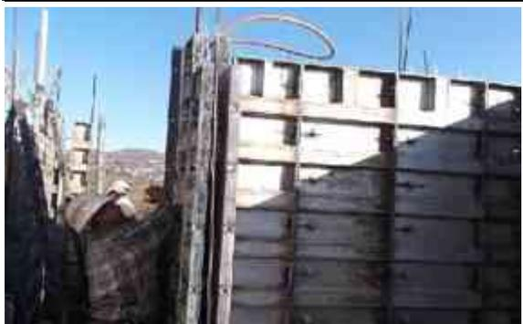
En remates de muro y vanos de puertas y ventanas se emplean tapas horizontales y/o verticales para sellar dichos elementos.
