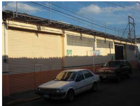
Foto del autor 3. Fachada del antiguo rastro Municipal.
