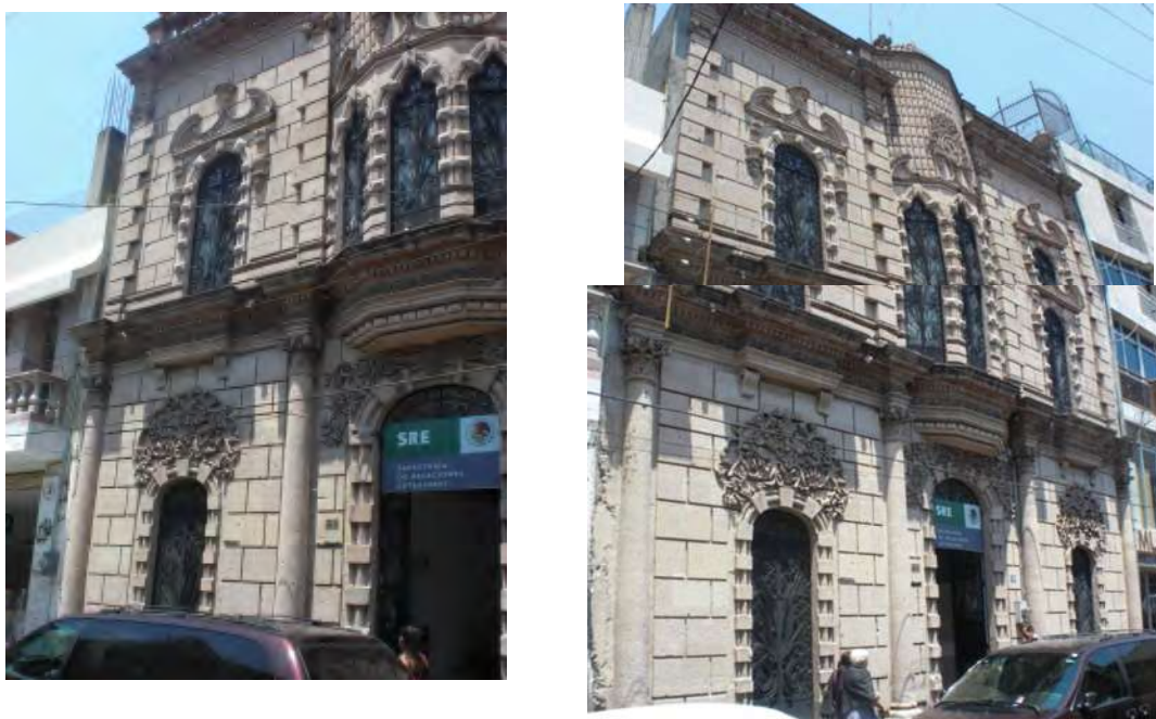
Fotografía del autor 6. Fachada edificio donde se albergan actualmente las oficinas descentralizadas del municipio.
