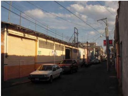
Foto del autor 2. Fachada del antiguo rastro Municipal.
