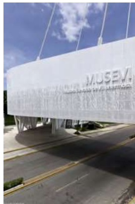
Foto 1 Aplicación de Screen Panel
