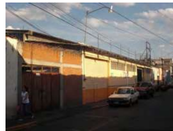
Foto 8. Fotografía Servicios, Infraestructura sobre la calle Jaime Nuno. Fotografía del autor.
