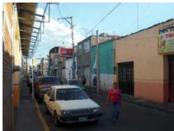
Foto 7. Fotografía Servicios, Infraestructura sobre la calle Jaime Nuno. Fotografía del autor.
