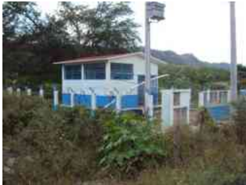
Imagen 13. Casa de Bombeo de la Galería Filtrante. Foto: Edgar Palomino.
