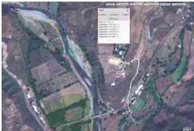
Imagen 25. Malecón faltante. Aprox. 600 metros. Foto: http://mapasims.sgm.gob.mx:8399/sismotectonica/
