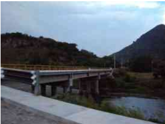
Imagen 9 Puente Tuzantla. Foto: Edgar Palomino
