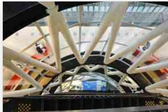
Fig. 103 Estructura de acero en la Mediateca de Sendai. Fotografía: <http://www.jmhdezhdz.com/2012/01/sendai-mediatheque-toyo-ito-mediateca.html>
