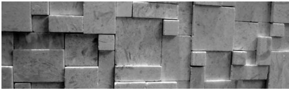
Imagen 33.-Muro de bloques de Cantera.
