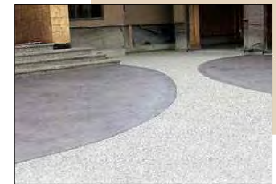
Piso de concreto aparente lavado con cepillo
