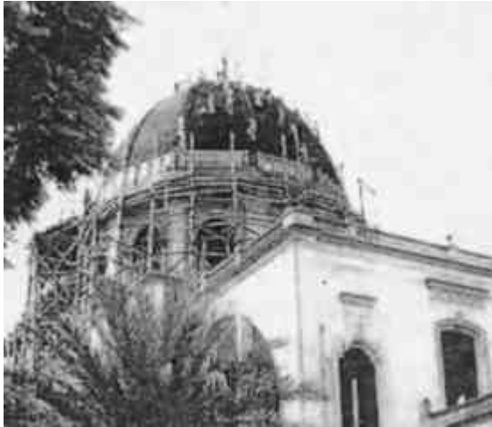
Imagen 86-Construcción de cúpula del Sr. de La Piedad
