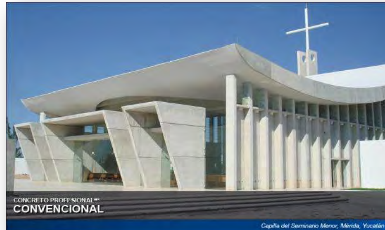
Fig.64. En esta imagen se muestra algunas aplicaciones del concreto convencional, este concreto puede lograr grandes texturas, y es ideal para cualquier construcción. Fuente: concretos Cemex.
