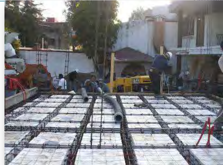
Fig.72. Vista de la Construcción de una Losa Reticular con Casetones de Poliestireno, Fuente: CUARR Infraestructura S. A DE C.
