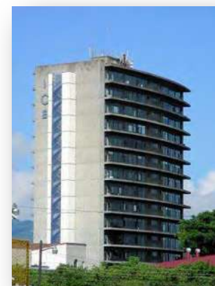
Fig. 3. Edificio del Instituto Costarricense de Electricidad.
