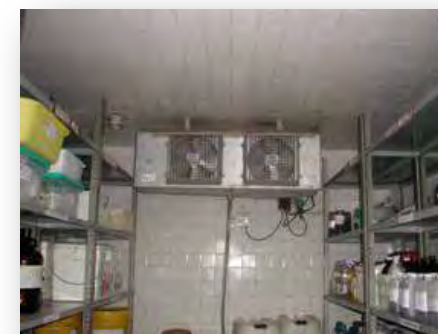
Fig.82. Cuarto de mantenimiento e intendencia. Fuente: http://eventos.iingen.unam.mx/Informe2005_2006/D_2_Programa_gral_de_mantenimiento.html
