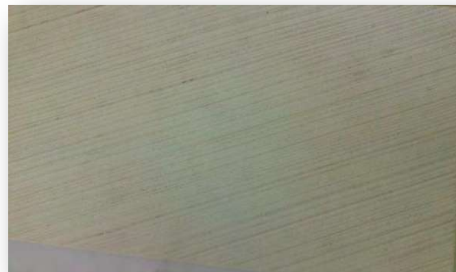
Fig.67. Vista del Acabado Pluma Ya Terminado, Aplicado En Muros, A Utilizarse en Área Administrativa. Fuente: Foto Autor.
