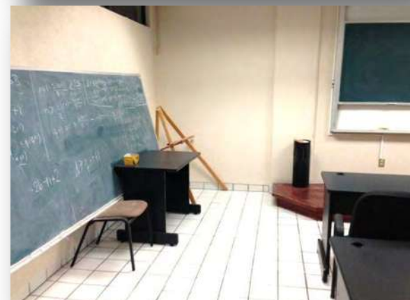
Fig.0. Se muestra la Improvisación en aulas por Falta de espacios para alumnos y profesores, falta de planeación en las instalaciones, espacios concurridos que saturan el edificio.
