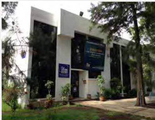
Fig. 6. Edificio Existente por parte del IFM, En Ciudad Universitaria. Fuente: Autor
