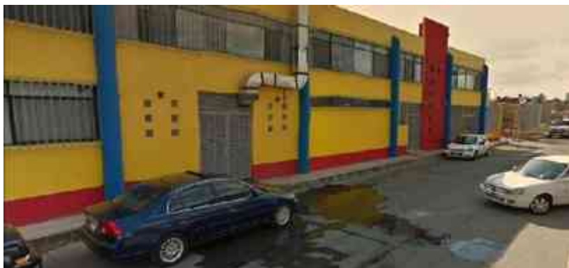
Imagen 27. Fachada exterior de la Guardería [Fuente: Archivo de autor]
