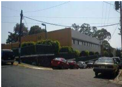
Imagen 13: Fachada de la guardería, tomadas por el autor
