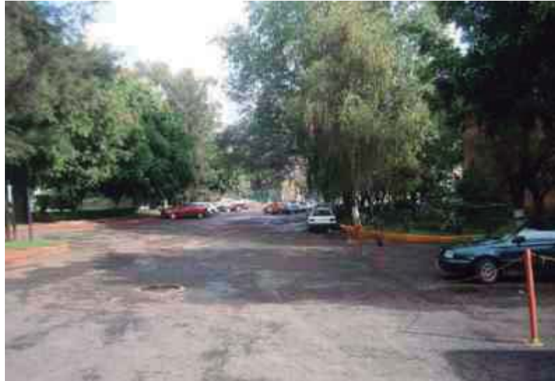
Imagen 38, fotografía de la parte posterior al teatro Morelos, esta zona presenta encharcamientos en tiempo de lluvias
