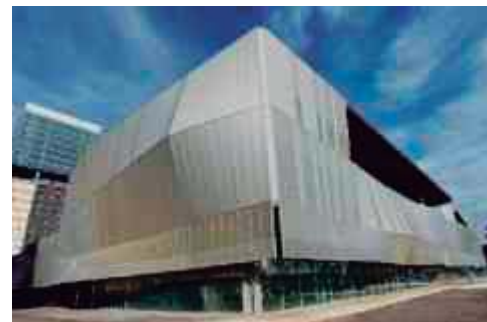
Imagen 26, Vista exterior del centro de convenciones
