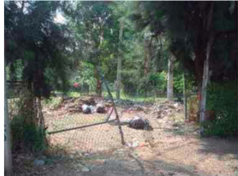
Imagen 45, periferia del centro de convenciones, sobre la calle pirindas, donde se aprecia la falta de mantenimiento y la importancia de circular todo el perímetro del complejo de manera de generar seguridad a los usuarios
