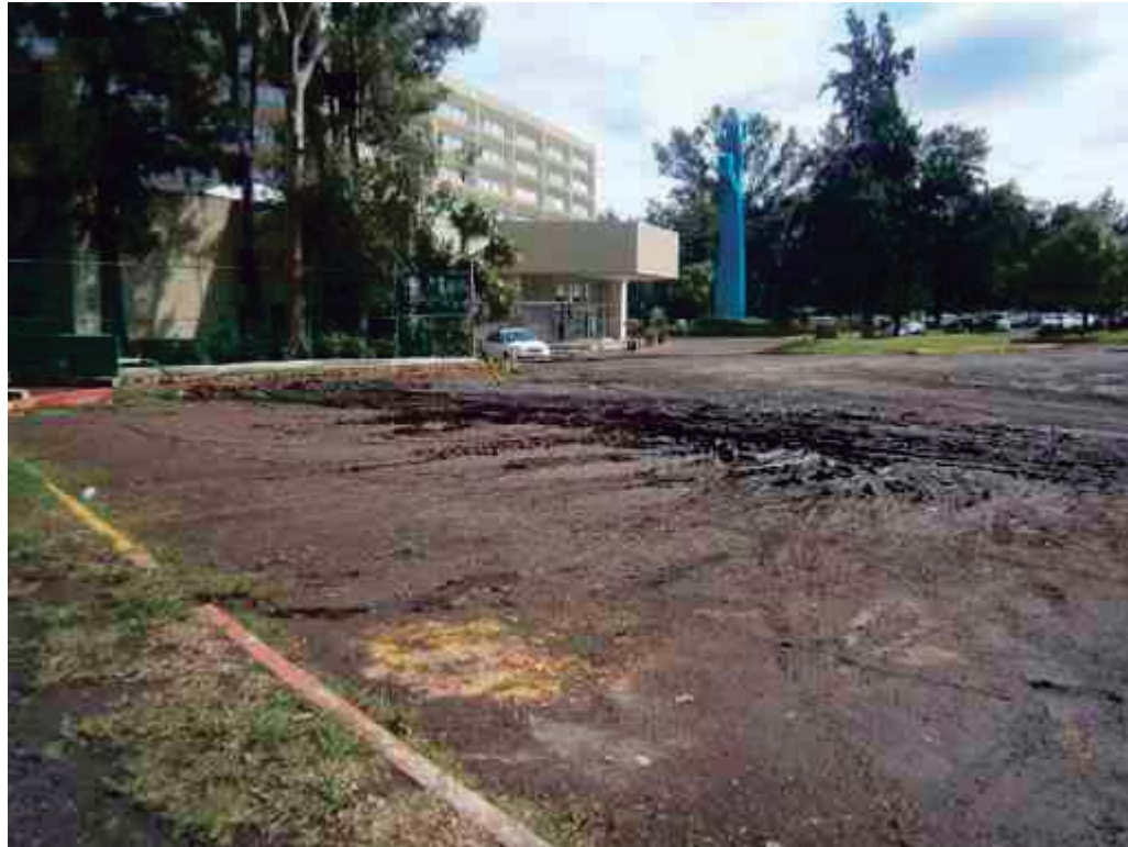
Imagen 19, zona de encharcamiento frente al hotel western best, en la parte posterior del teatro
