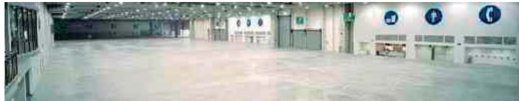
Imagen 23, sala de 34,000 m 2 libre de columnas
