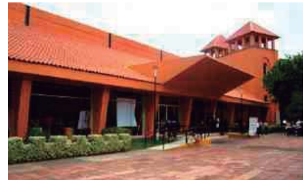
Imagen 8 Expocentro, edificio más reciente del conjunto cuenta con una superficie de 4,522 m 2 , con capacidad para 220 stands. Fotografía tomada en septiembre 2013
