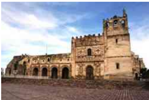
Imagen 9 Fachada del ex convento de San Agustín. Fuente, https://www.flickr.com/photos/quokant/4369059345/in/photostream/
