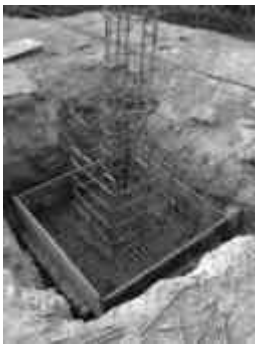
Imagen 29 Zapata aislada
