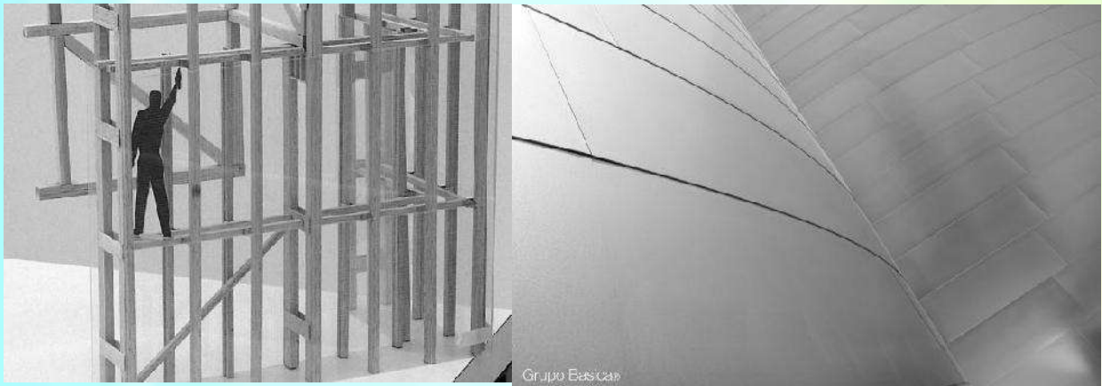
Fig. 28,Perfiles de Acero y Láminas ya Colocadas, Foto EDGM
