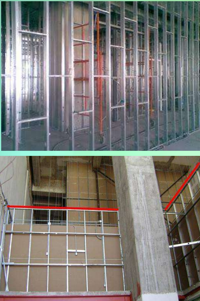
Fig. 25,Bastidores para muros, Foto EDGM
