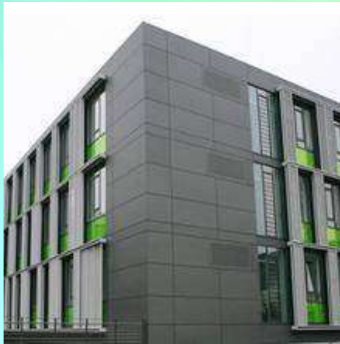
Fig. 32,Perfiles para Láminas en Fachadas, Foto EDGM
