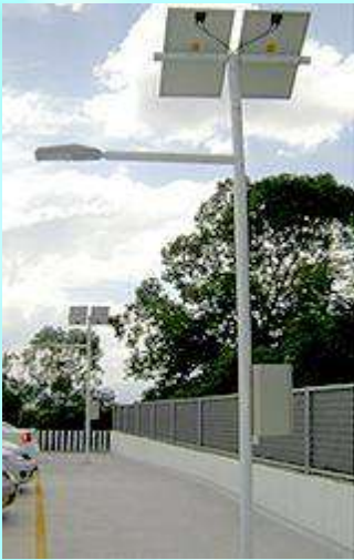
Fig. 35,Alumbrado público con paneles solares y paneles solares, Foto EDGM
