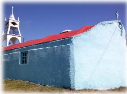
Figura 8 Grietas de la parte posterior de la Capilla de Toluquilla. Foto tomada por Elizabeth Negrete Herrera. 05/12/2013
