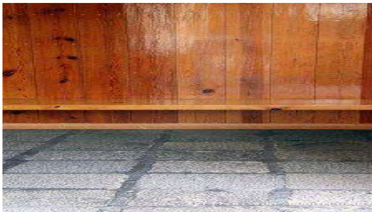
Figura 46 Detalle del banco “flotando” adyacente a la pared de madera.
