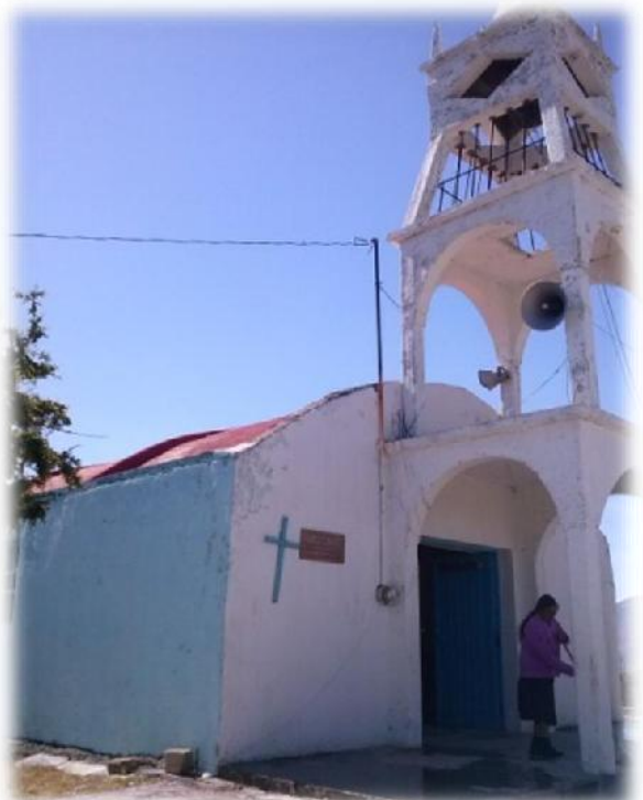
Figura 1 Capilla de Toluquilla, Localidad de Maravatio Mich. Foto tomada por Elizabeth Negrete Herrera. 07/01/2014
