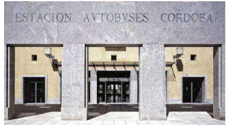
Imagen No.9 Fachada Estación de Autobuses Cordoba España
