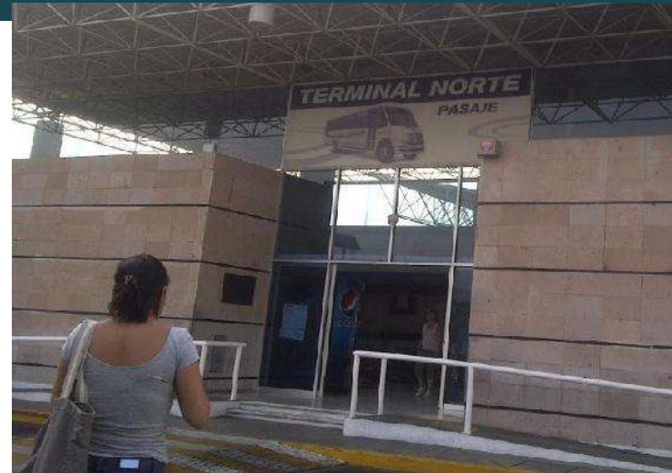
Imagen No. 20 Fachada de Estación de Autobuses Norte Morelia
