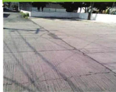
27/CALLE DE CONCRETO/ARS ADOQUIN/ARS
