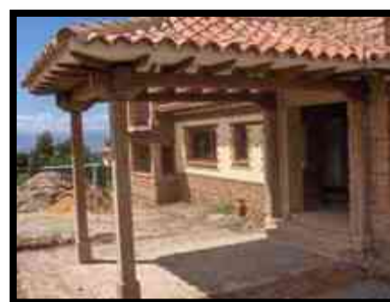
Imagen. 97: Cubierta de teja de barro rojo recocido.
