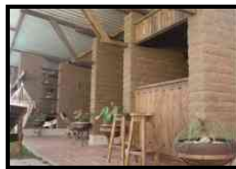
Imagen. 96: Muro de adobe en interior.
