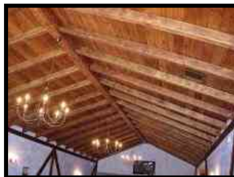
Imagen. 98: Cubierta de madera con vigas y largueros.
