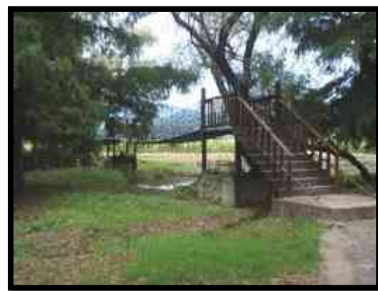
Imagen. 22: Puente colgante que atraviesa parte del lago.
