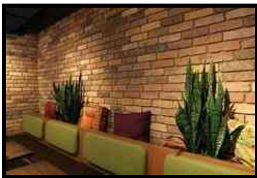
Imagen. 93: Muro de tabique aparente en interior.
