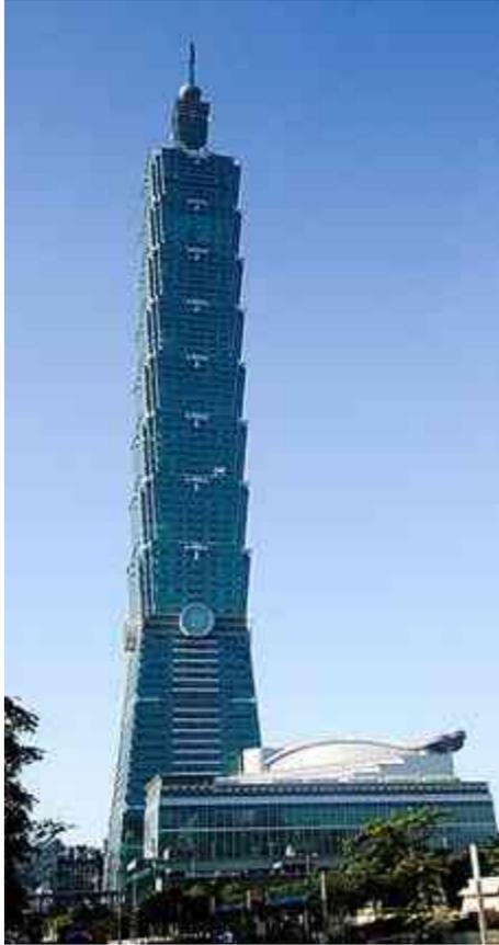
sus técnicos puede soportar terremotos de hasta 7 grados en la escala de Richter y vientos de más de 450 km/h. Cuenta con adelantos tecnológicos y uno de los más seguros, debido a que cuenta con un sencillo pero eficaz amortiguador estabilizado, un amortiguador de una masa destinado a contrarresta los efectos de los huracanes y temblores de tierra sobre el edificio.<sup>140</sup>
