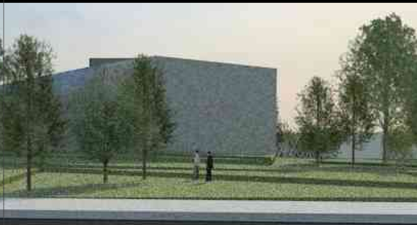
Fachada poniente de Norte a Sur
