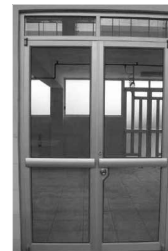
Puerta en perfil tubular de aluminio y cristal, en dos hojas, color natural, 180 x 2.30 cm.
