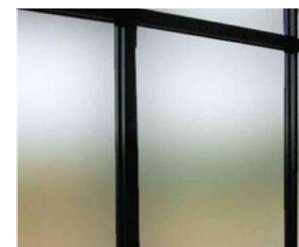
Ventanal en perfil tubular cuadrado de aluminio y cristal, esmerilado, 3m de altura.
