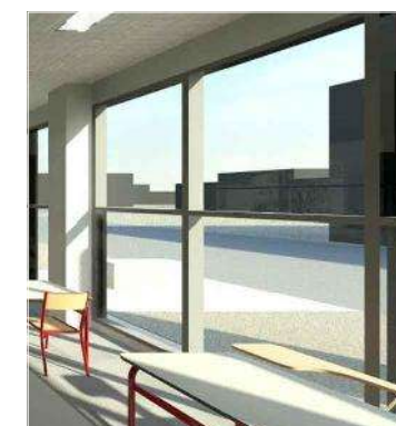
Ventanal en perfil tubular cuadrado de aluminio y cristal, color natural, con puerta de los mismos materiales en algunos casos, 3m de altura.
