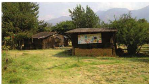
Imagen 01: Fotografía tomada en sitios proporcionada por el Instituto de la Infraestructura Física Educativa del Estado de Michoacán. Tomada el 25 de mayo de 2013
