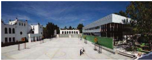
Imagen 08: Vista del área deportiva en la cual se aprecia los elementos antiguos y nuevos que forman el edificio. Fuente: http://www.gutierrez-alonso.com/restauracion_escolar11.html
