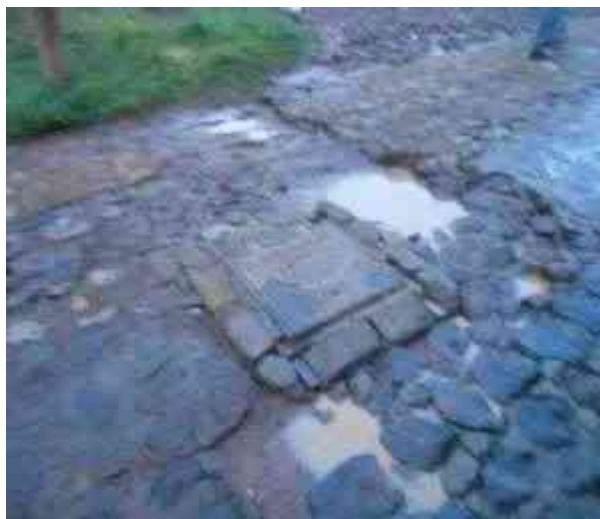
Fig. Agua potable, fotografía tomada por María Fernanda León G.
