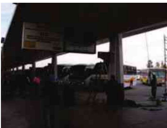
Fig. 43 Central camionera de Irapuato, andenes.
