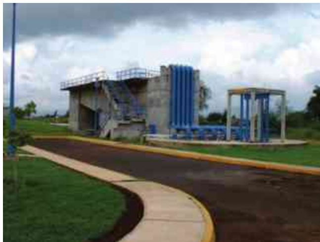
Fig. 22 La Planta de Tratamiento de Aguas Residuales Santa Bárbara.
