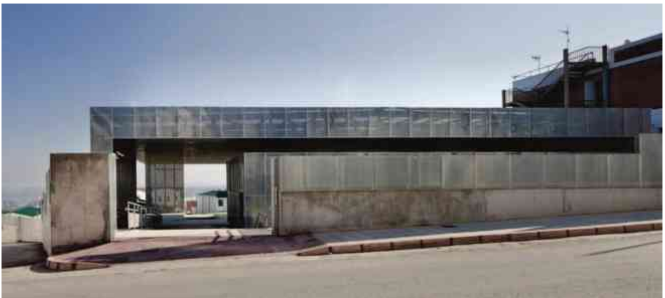
Fig. 33 Fachada transparente de la central de Porcuna, España. Archdaily.
