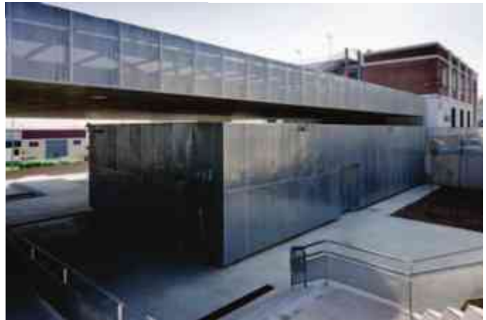
Fig. 32 Central de Autobuses de Porcuna, España. Archdaily.
