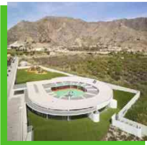
Ilustración 1: Vista aérea guardería alicantina Fuente: http://www.archdaily.mx/250562/nursery-school-rocamora-arquitectura
